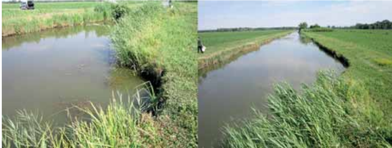
Fig. 74. Crollo di capezzagne dovuto all'attività di scavo del gambero invasivo Procambarus clarkii nella Bassa Friulana (zona Alberoni). Fig. 74. Collapsed headland caused by the digging activities of invasive crayfish Procambarus clarkii in the Bassa Friulana (Alberoni area).
