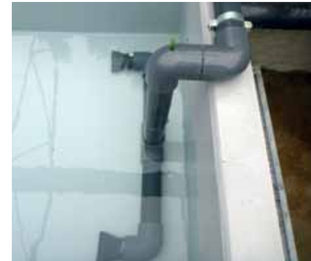
Fig. 14. I tubi di mandata dell'acqua alle vasche sono state adattate per generare un flusso laminare sul fondo e arricchire l'acqua di ossigeno.
