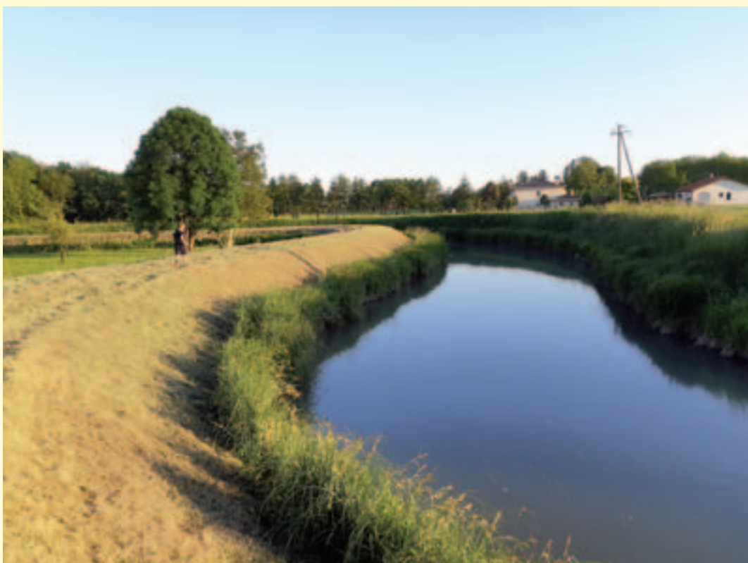
Figura 5.16 – Manutenzione gentile della vegetazione di sponda lungo il Fiume Zero. Si nota la vegetazione lasciata al piede di sponda. (Fonte: Consorzio di Bonifica Acque Risorgive)
