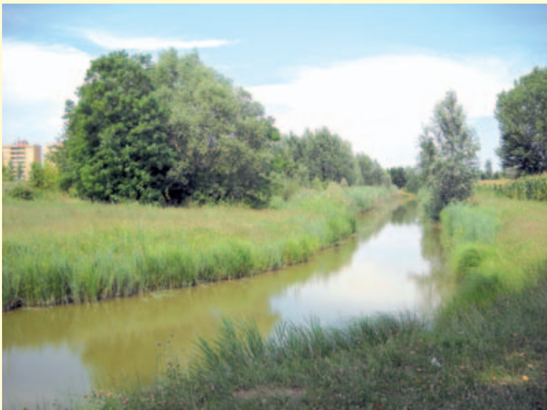
Figura 1.5 – Rimozione del rivestimento spondale in calcestruzzo, allargamento di sezione e creazione di golene allagabili colonizzate da vegetazione palustre lungo il Collettore Favaro. Nella serie di immagini è possibile vedere il canale prima dei lavori, con le sponde cementificate, le golene allagabili appena create al termine dei lavori e a seguire l'inizio della colonizzazione da parte della vegetazione palustre e riparia. (Fonte: Consorzio di Bonifica Acque Risorgive)
