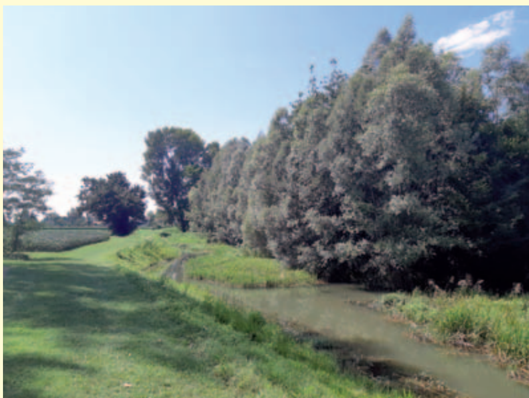
Figura 1.12 – Allargamento di sezione mediante creazione di una banchina allagabile. Nelle immagini è possibile vedere il canale allargato al termine dei lavori e l’inizio della colonizzazione da parte della vegetazione riparia. (Fonte: Consorzio di Bonifica Acque Risorgive)
