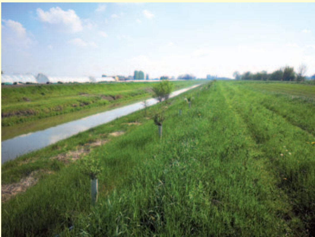
Figura 4.10 – Messa a dimora sul ciglio di sponda di filari arbustivi lungo i seguenti canali (in ordine di foto): Collettore Alfieri (Comune di Gualtieri – Provincia di Reggio Emilia); Cavata Orientale (in primo piano la banchina allagabile appena creata) (Comune di Carpi – Provincia di Modena); Diversivo Fossa Nuova Cavata, in cui si evidenzia un trifilare posto sul nuovo rilevato arginale, realizzato dopo la creazione della banchina allagabile in primo piano (Comune di Carpi – Provincia di Modena); Collettore Acque Basse Modenesi (Comune di Novi di Modena e Comune di Carpi – Provincia di Modena). (Fonte: Consorzio di Bonifica dell'Emilia Centrale)
