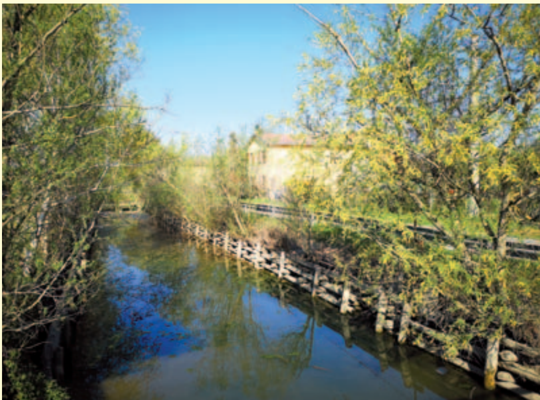
Figura 2.16 – Realizzazione di una palificata semplice rinverdata con palo frontale verticale lungo il Canale di Budrione (Comune di Carpi – Provincia di Modena). Nelle prime due immagini è possibile vedere il canale prima dell'intervento, con le sponde erose, e a seguire la palificata a distanza di 3 anni dalla realizzazione del progetto. Nelle due immagini successive si può vedere lo sviluppo della vegetazione dopo 5 (2009) (durante il periodo irriguo) e 16 anni dalla realizzazione dell'intervento (2020). (Fonte: Consorzio di Bonifica dell'Emilia Centrale)
