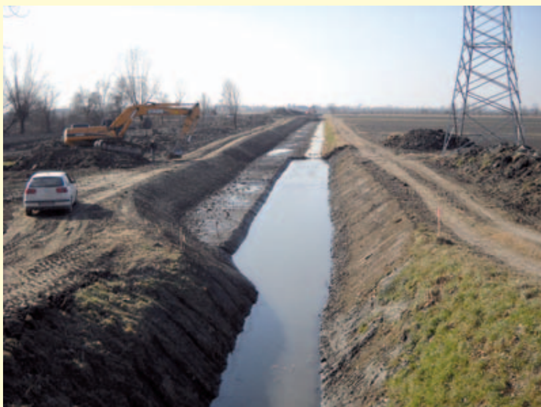
Figura 1.18 – Allargamento di sezione e creazione di banchine allagabili nei canali Scolo Condotto di mezzo (in alto) e Scolo Bonaventura (immagini seguenti). Nelle immagini è possibile vedere lo stato dei canali durante l'esecuzione dei lavori di creazione delle banchine allagabili. (Fonte: Consorzio di Bonifica Adige Euganeo)
