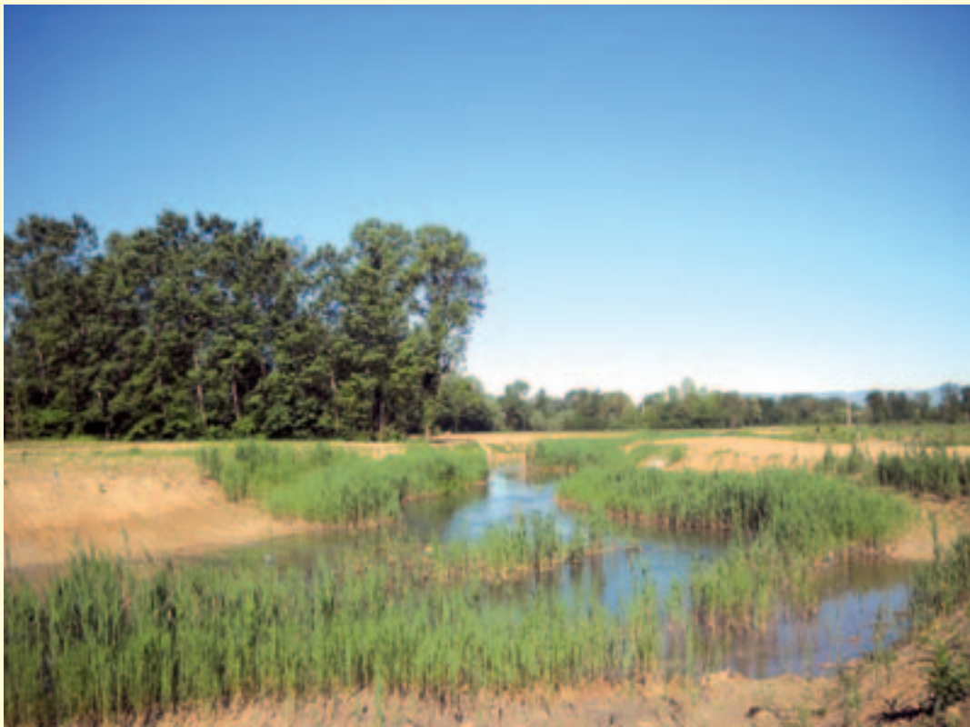
Figura 1.6 – Allargamento di sezione del Fiume Zero e creazione di golene allagabili colonizzate da vegetazione palustre. Nelle immagini è possibile vedere il canale allargato al termine dei lavori, con l'argine originariamente posto a ridosso dell'alveo di magra ora arretrato per creare la golena allagabile, e a seguire l'inizio della colonizzazione da parte della vegetazione palustre. (Fonte: Consorzio di Bonifica Acque Risorgive)
