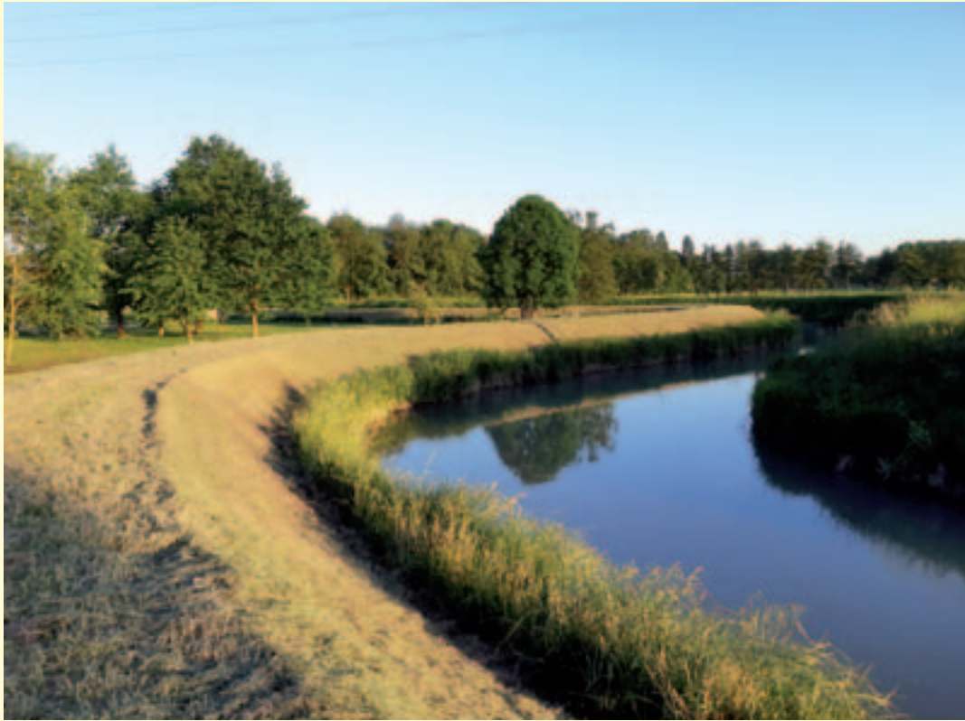
Figura 5.5 – Fascia di vegetazione palustre al piede di sponda nei tratti arginati. Fiume Dese a Scorzè. (Fonte: Consorzio di Bonifica Acque Risorgive).
