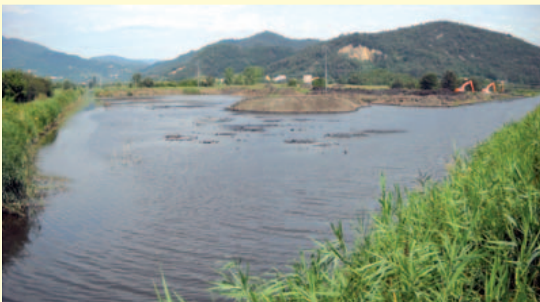
Figura 3.18 – Zona umida Cingolina a Galzignano Terme. Nelle immagini è possibile apprezzare lo schema di progetto e i lavori di scavo a profondità diverse dell'area, successivamente colonizzata da parte delle specie vegetali palustri e acquatiche. (Fonte: Consorzio di Bonifica Adige Euganeo)
