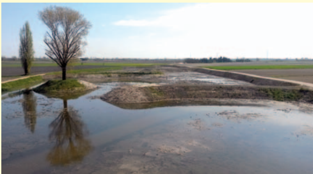
Figura 3.17 – Zona umida Canale Sorgaglia. Nelle immagini è possibile apprezzare la zona umida vista dall'alto e la colonizzata da parte delle specie vegetali palustri e acquatiche. (Fonte: Consorzio di Bonifica Adige Euganeo)
