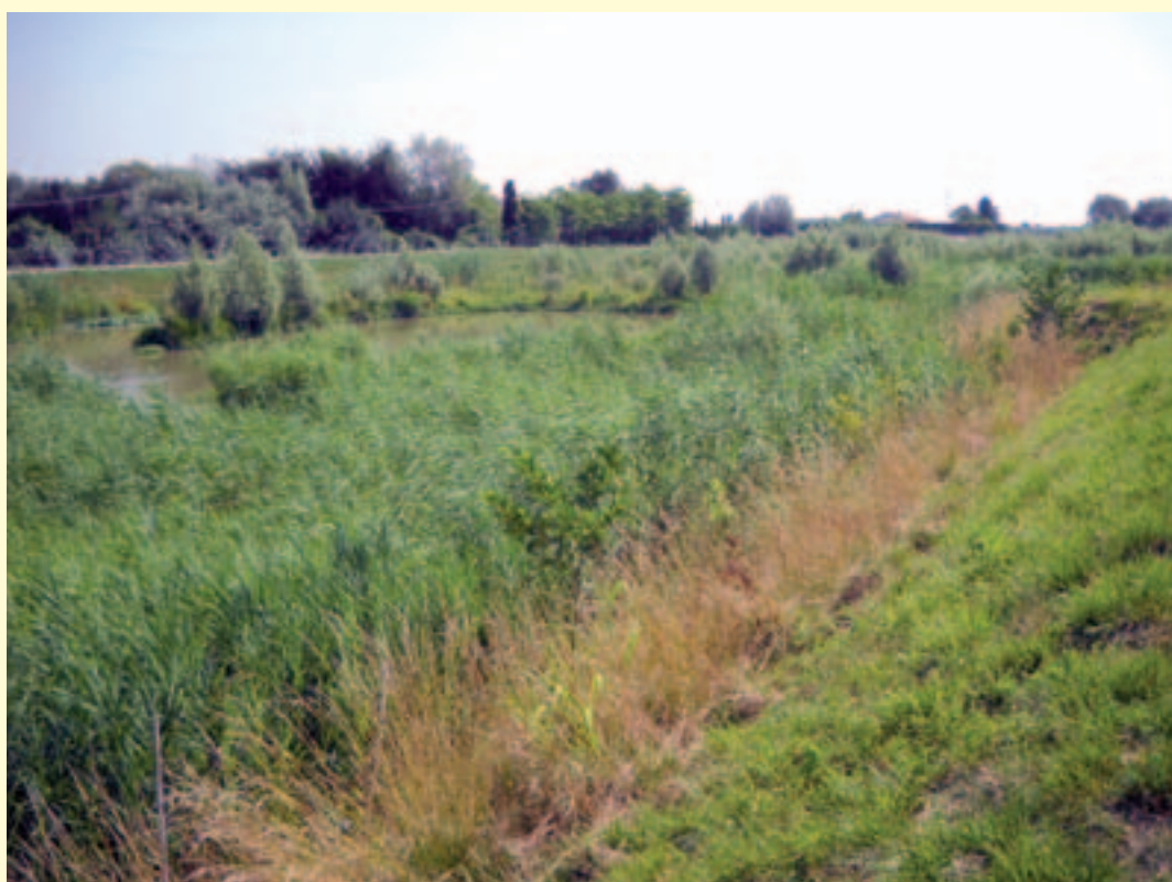
Figura 1.8 – Allargamento di sezione dello Scolo Pionca e creazione di golene allagabili colonizzate da vegetazione palustre. Nelle due serie di immagini è possibile vedere il canale allargato al termine dei lavori e l'inizio della colonizzazione da parte della vegetazione palustre. L'argine originariamente rettilineo e posto a ridosso dell'alveo di magra è stato arretrato per creare la golena allagabile. (Fonte: Consorzio di Bonifica Acque Risorgive)
