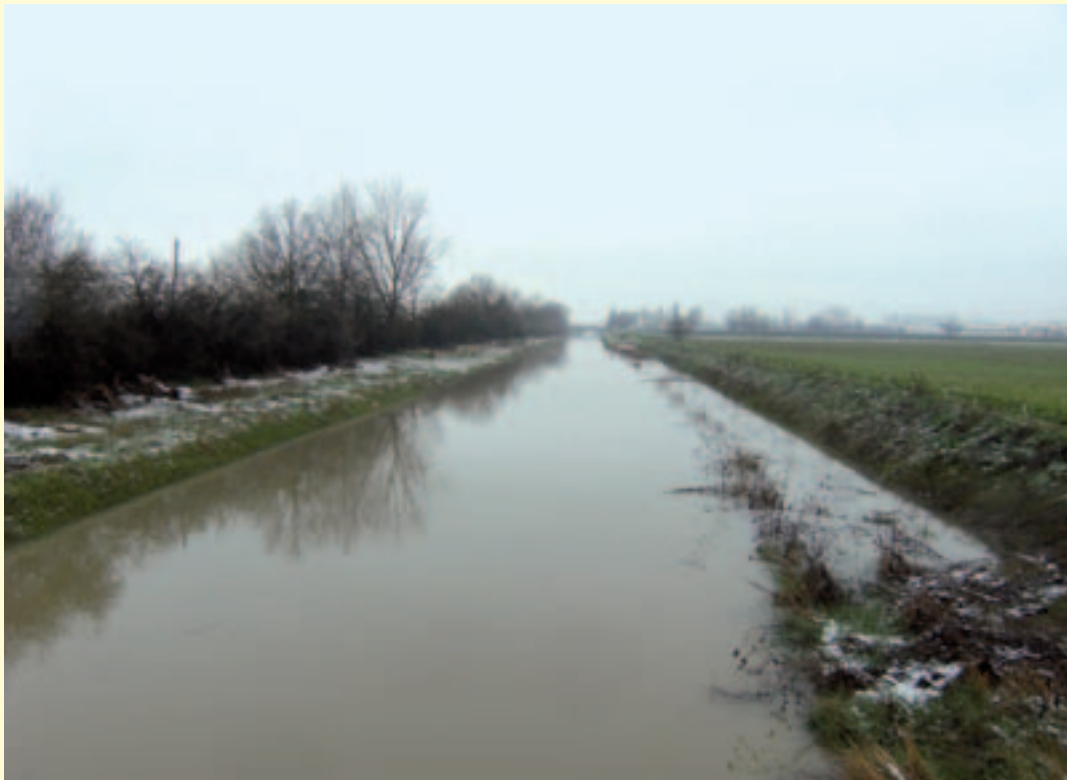
Figura 1.25 – Creazione di una banchina interna allagabile lungo il Collettore Acque Basse Modenesi (Comune di Carpi e Comune di Novi di Modena – Provincia di Modena). Nelle immagini è possibile vedere il canale prima dell'intervento (2015) e lo stesso dopo 4 anni (2020), con la vegetazione pioniera che inizia a colonizzare la banchina e un evento di piena che evidenzia l'invaso della stessa, in confronto con la sponda opposta non riprofilata. (Fonte: Consorzio di Bonifica dell'Emilia Centrale)
