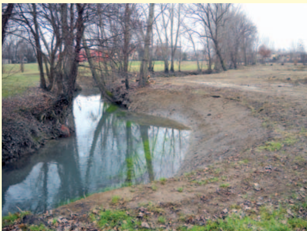
Figura 1.13 – Allargamento di sezione lungo corsi d'acqua privati. Nelle immagini è possibile vedere i lavori di allargamento appena realizzati mediante diminuzione di pendenza della sponda. (Fonte: Consorzio di Bonifica Acque Risorgive)
