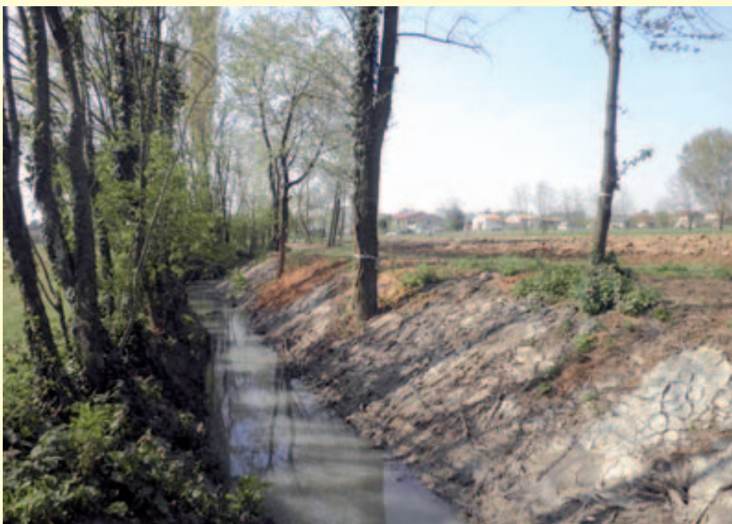
Fig. 5.24 – Intervento di manutenzione della vegetazione eseguito sul Rio Bombena atto a preservare la fascia arboreo-arbustiva, utile per favorire l'ombreggiamento dell'alveo. (Fonte: Consorzio di Bonifica Piave)
