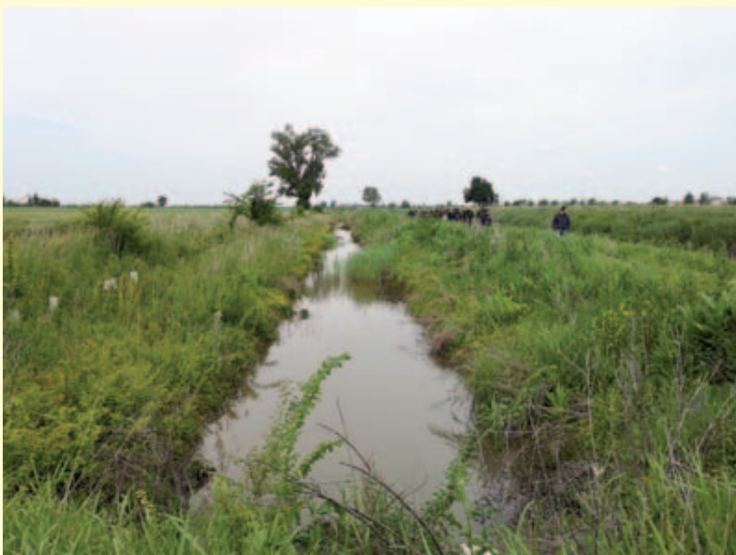
Figura 3.32 – Creazione di una cassa di espansione a fini multipli lungo la Cavata Orientale (Comune di Carpi – Provincia di Modena) e di bassure umide lungo il Collettore Alfieri (Comune di Gualtieri – Provincia di Reggio Emilia). Nelle prime due immagini è possibile vedere la cassa di espansione appena realizzata (2018), in cui si nota la zona umida costruita con diverse profondità del fondo e la messa a dimora all'interno dell'invaso di piantine di salice bianco (protetto da shelter plastici). Nelle successive foto si può invece vedere la realizzazione di 8 bassure umide parallele al Collettore Alfieri e connesse con lo stesso tramite tubazioni poste sul fondo, costruite su una banchina di proprietà del Consorzio (a sinistra nella prima foto), che dopo la realizzazione dell'intervento hanno iniziato ad essere invase dalle acque di piena o irrigue e progressivamente colonizzate dalla vegetazione acquatica e spondale. (Fonte: Consorzio di Bonifica dell'Emilia Centrale)
