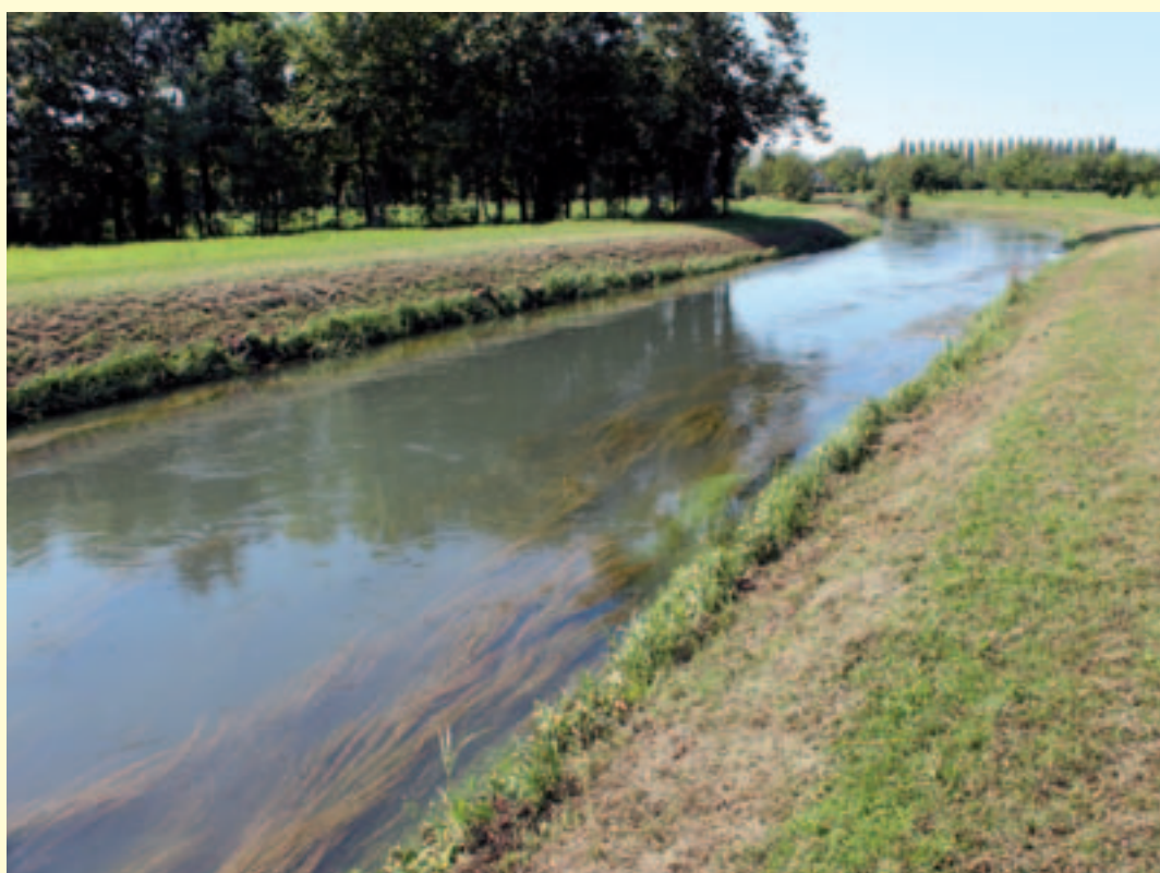
Figura 5.19 – Interventi di sfalcio della vegetazione acquatica lungo il fiume Meolo, in alto, e il fiume Musestre, in basso: da aprile a giugno si esegue un taglio parziale nel tratto centrale lasciando un margine di 50 cm dalle sponde. (Fonte: Consorzio di Bonifica Piave)
