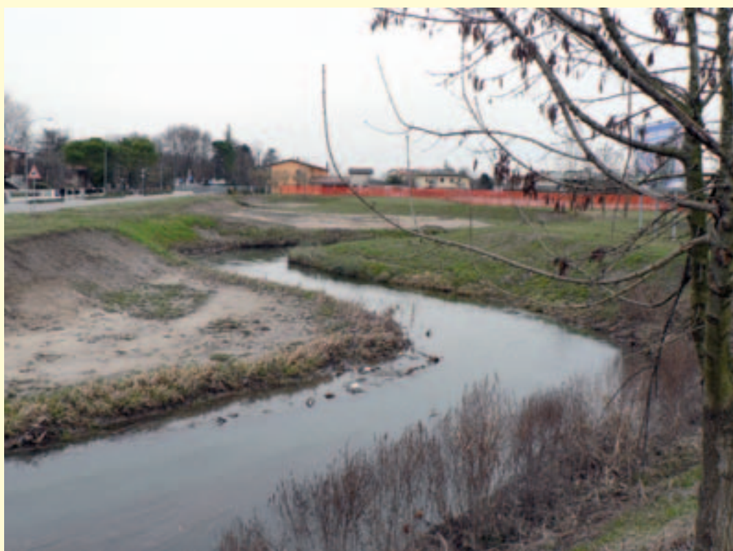
Figura 1.14 – Lavori di realizzazione di golene allagabili lungo la Roggia Versiola. (Fonte: Consorzio di Bonifica Veneto Orientale)
