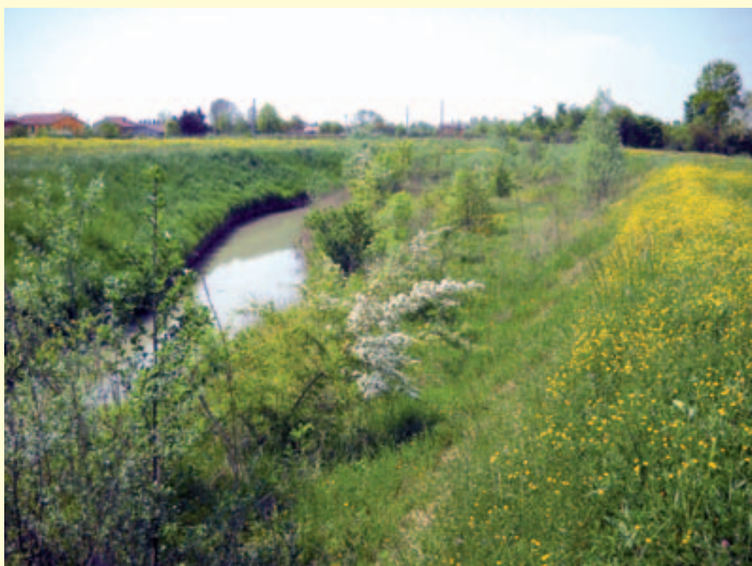
Figura 1.11 – Allargamento di sezione del Rio Storto mediante creazione di una banchina allagabile. Nelle immagini è possibile vedere il canale allargato al termine dei lavori e l’inizio della colonizzazione da parte della vegetazione riparia. L’argine originariamente posto a ridosso dell’alveo di magra è stato arretrato per creare una banchina allagabile. (Fonte: Consorzio di Bonifica Acque Risorgive)
