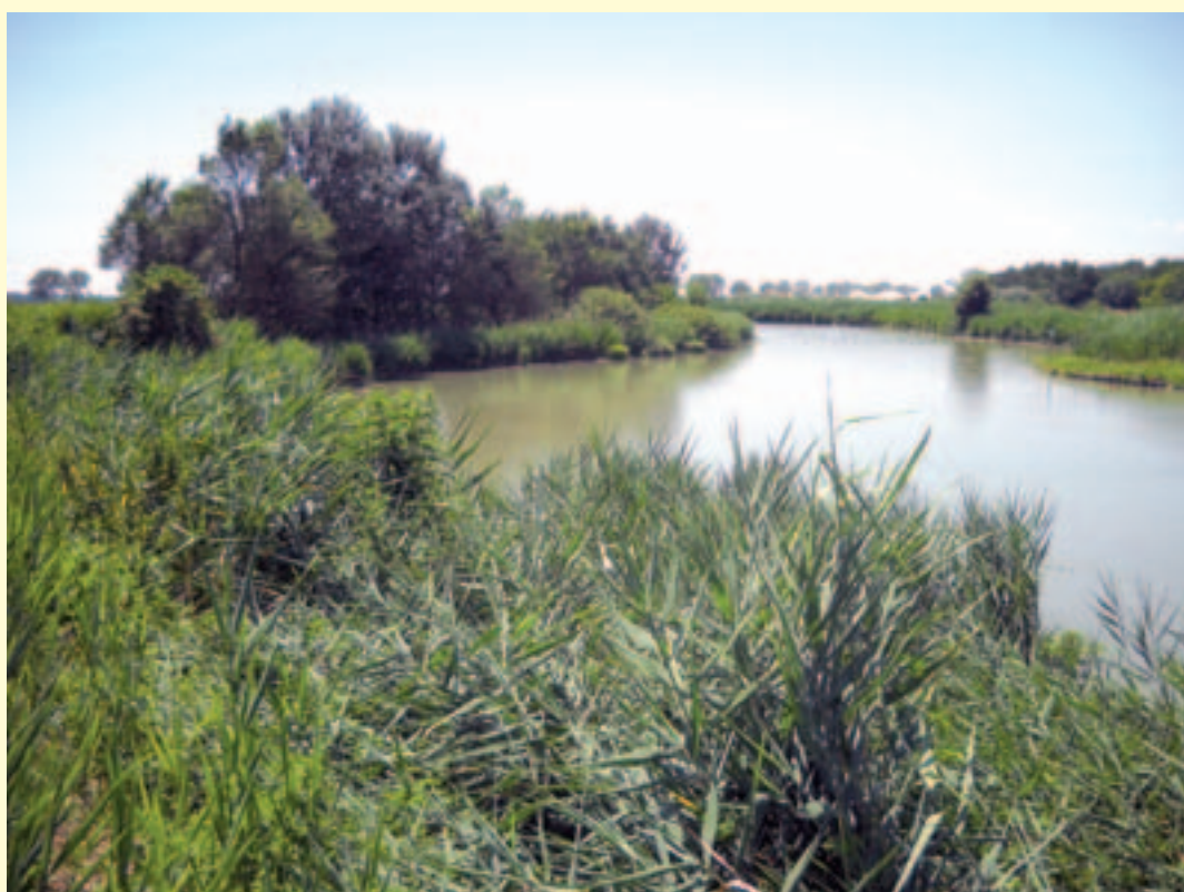
Figura 1.10 – Allargamento di sezione del fiume Zero a Quarto d'Altino (VE) mediante creazione di una banchina allagabile. Nelle due immagini è possibile vedere la banchina allagabile appena creata e lo stato attuale del fiume a distanza di alcuni anni, colonizzato da vegetazione palustre e riparia. (Fonte: Consorzio di Bonifica Acque Risorgive)
