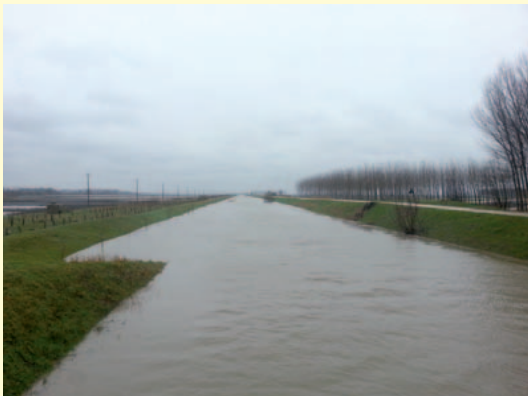
Figura 1.19 – Allargamento di sezione e creazione di banchine allagabili lungo la Fossa Maestra. Nella serie di immagini è possibile vedere il canale prima degli interventi (sezione trapezoidale) e a seguire la banchina interna creata ex novo e allagata durante alcuni eventi meteorici. (Fonte: Consorzio di Bonifica Veronese)
