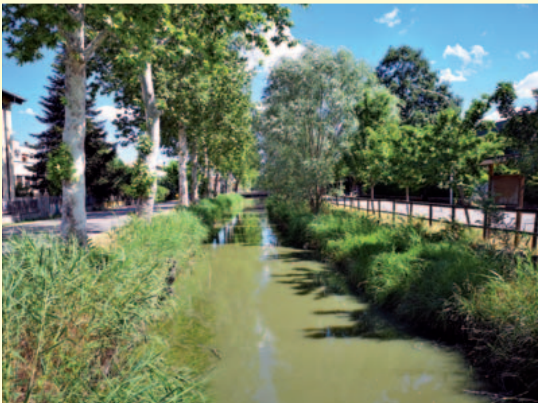
Figura 1.26 – Creazione di una banchina interna allagabile lungo il Canale di San Giovanni (Comune di San Giovanni in Persiceto – Provincia di Bologna). Nella prima foto è possibile vedere lo stato al 2020 del canale riqualificato, con la vegetazione, anche arborea, presente all'interno della sezione. Nelle successive due immagini è possibile vedere il canale prima dell'intervento (2008) e a distanza di 12 anni (2020). Si nota la palificata che ha permesso di ricavare lo spazio per la creazione della banchina e per la messa a dimora di vegetazione acquatica, spondale e arbustiva. (Fonte: Consorzio della Bonifica Burana e Consorzio di Bonifica Pianura di Ferrara)
