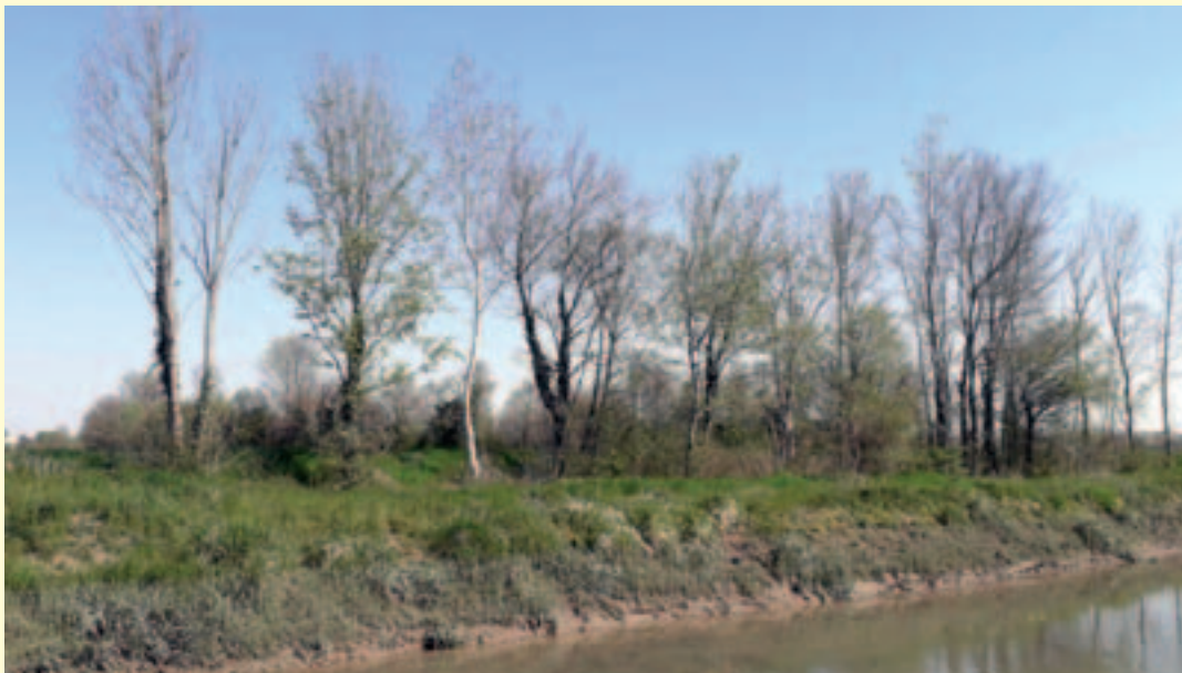
Figura 1.23 – Allargamento di sezione mediante creazione di banchine allagabili sullo Scolo Tesinella. Nelle immagini è possibile vedere le banchine al termine dei lavori di realizzazione. (Fonte: Consorzio di Bonifica Brenta)
