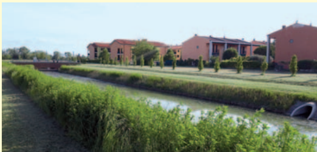
Figura 1.16 – Allargamento di sezione mediante creazione di banchine allagabili lungo il Canale Nuovo Meggiaro-Squacchielle. Nelle immagini è possibile vedere il canale allargato e le nuove banchine allagabili al termine dei lavori e l’inizio della colonizzazione da parte della vegetazione palustre. (Fonte: Consorzio di Bonifica Adige Euganeo)
