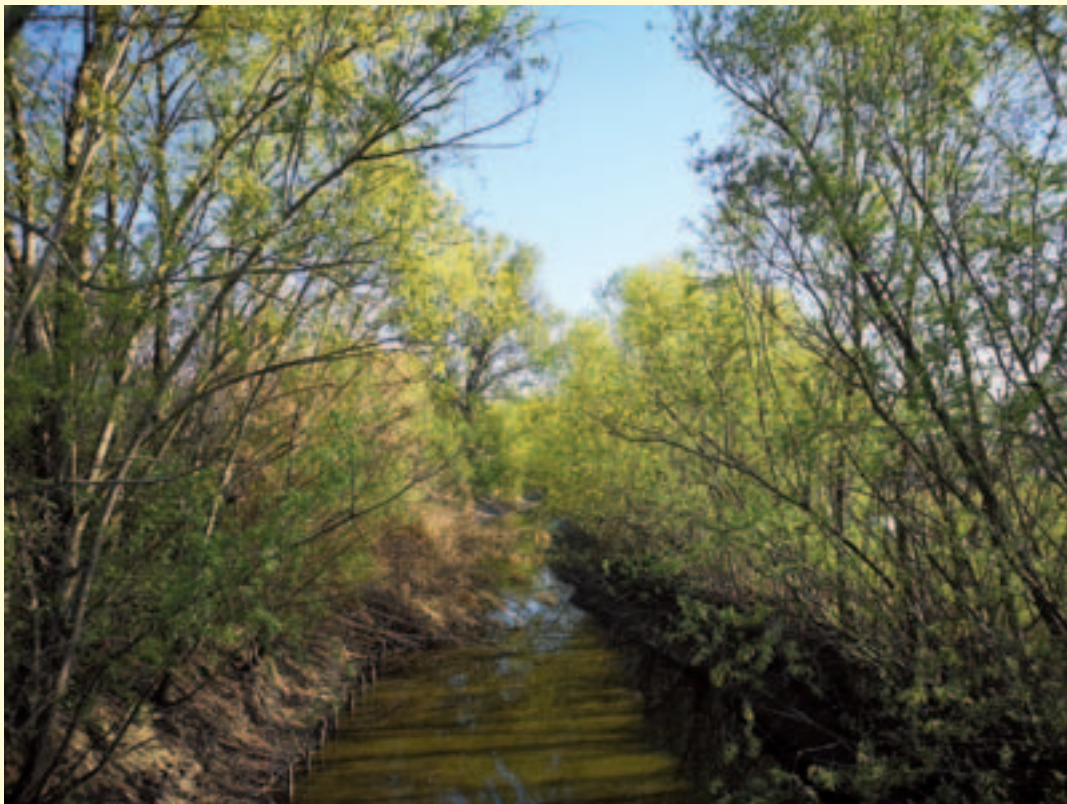
Figura 2.11 – Posa di copertura diffusa con astoni di salice lungo il Cavo Migliarina (Comune di Carpi – Provincia di Modena). Nelle immagini è possibile vedere la sponda destra del canale soggetta a problemi di dissesto, la posa degli astoni di salice, la sponda protetta mediante la copertura diffusa con astoni di salice a 5 anni dalla fine dei lavori e la medesima sponda nel 2020, a distanza di 16 anni dalla realizzazione dell'intervento. (Fonte: Consorzio di Bonifica dell'Emilia Centrale)
