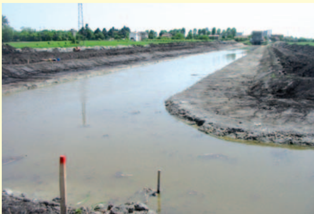
Figura 1.17 – Allargamento di sezione e creazione di golene nelle valli di Arquà Petrarca e Galzignano. Nelle immagini è possibile vedere lo stato del canale durante l'esecuzione dei lavori di creazione delle banchine allagabili. (Fonte: Consorzio di Bonifica Adige Euganeo)
