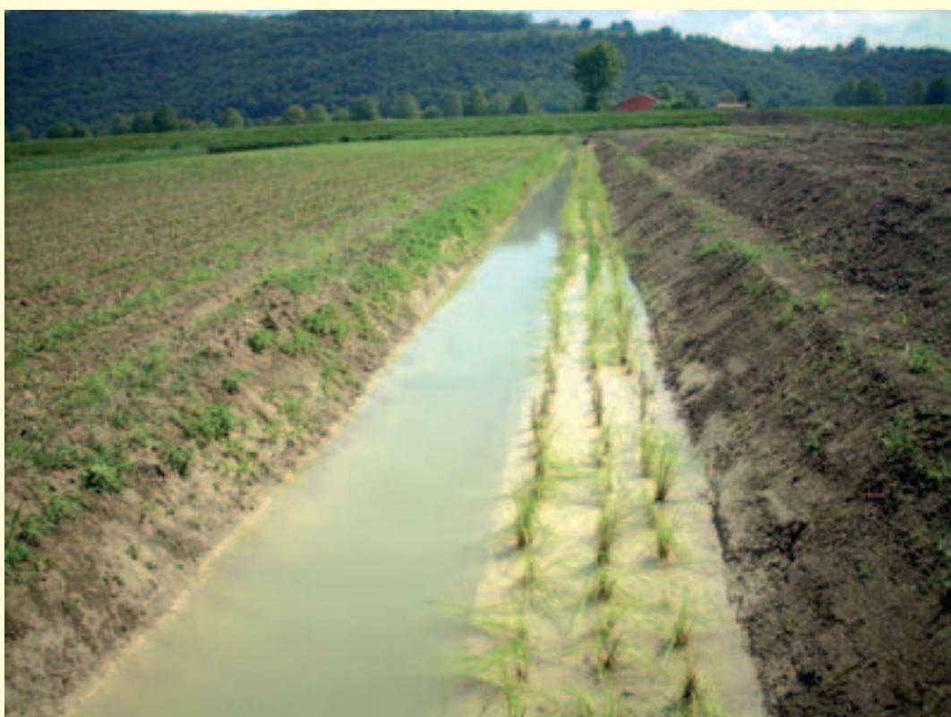
Figura 1.21 – Riqualificazione della Fossa di Mezzo mediante creazione di una banchina allagabile e la messa a dimora di specie elofitiche. (Fonte: Consorzio di Bonifica Alta Pianura Veneta. Foto: Studio Progea)
