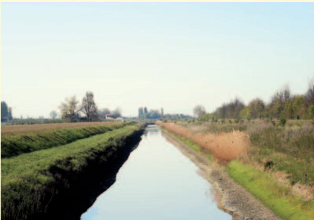
Figura 2.5 – Nelle prime due immagini è possibile vedere la riprofilatura della sponda eseguita lungo il Collettore Alfieri e a seguire lo stato del canale a distanza di alcuni anni dall'intervento: a sinistra della foto si nota il canneto lungo la sponda a bassa pendenza e a destra la sponda pressochè verticale non oggetto di intervento. Nelle successive due immagini è mostrata la riprofilatura della sponda realizzata lungo il Collettore Acque Basse Modenesi e la colonizzazione da parte della vegetazione dopo qualche anno: a destra dell'ultima foto si nota il canneto presente lungo la sponda riprofilata e a sinistra la sponda non oggetto di intervento. (Fonte: Consorzio di Bonifica dell'Emilia centrale)
