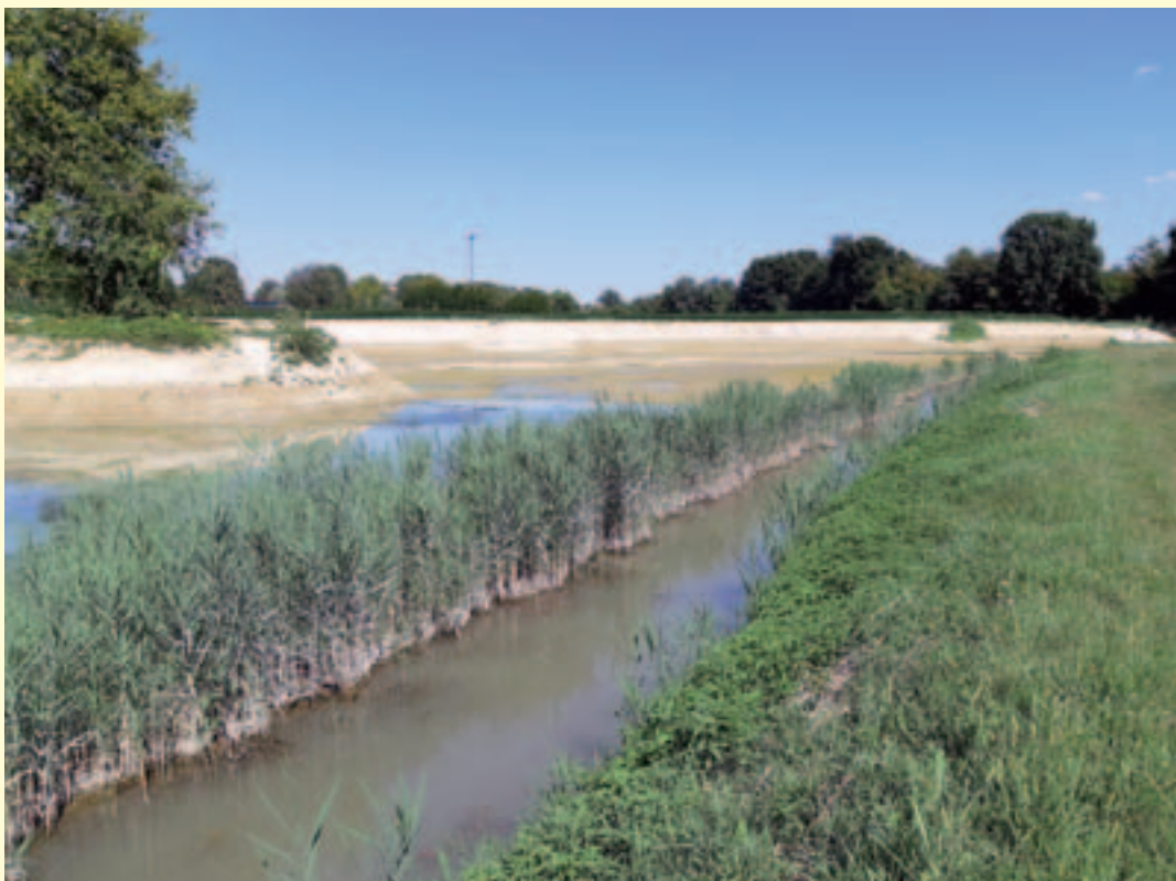
Figura 3.10 – Creazione di 3 zone umide in alveo lungo lo Scolo Orcone. Nella serie di immagini è possibile vedere la planimetria delle 3 wetland ed alcune sezioni di progetto; a seguire le zone umide al termine dei lavori, con il mantenimento ove possibile della vegetazione palustre presente lungo le sponde ante operam del canale. (Fonte: Consorzio di Bonifica Acque Risorgive)
