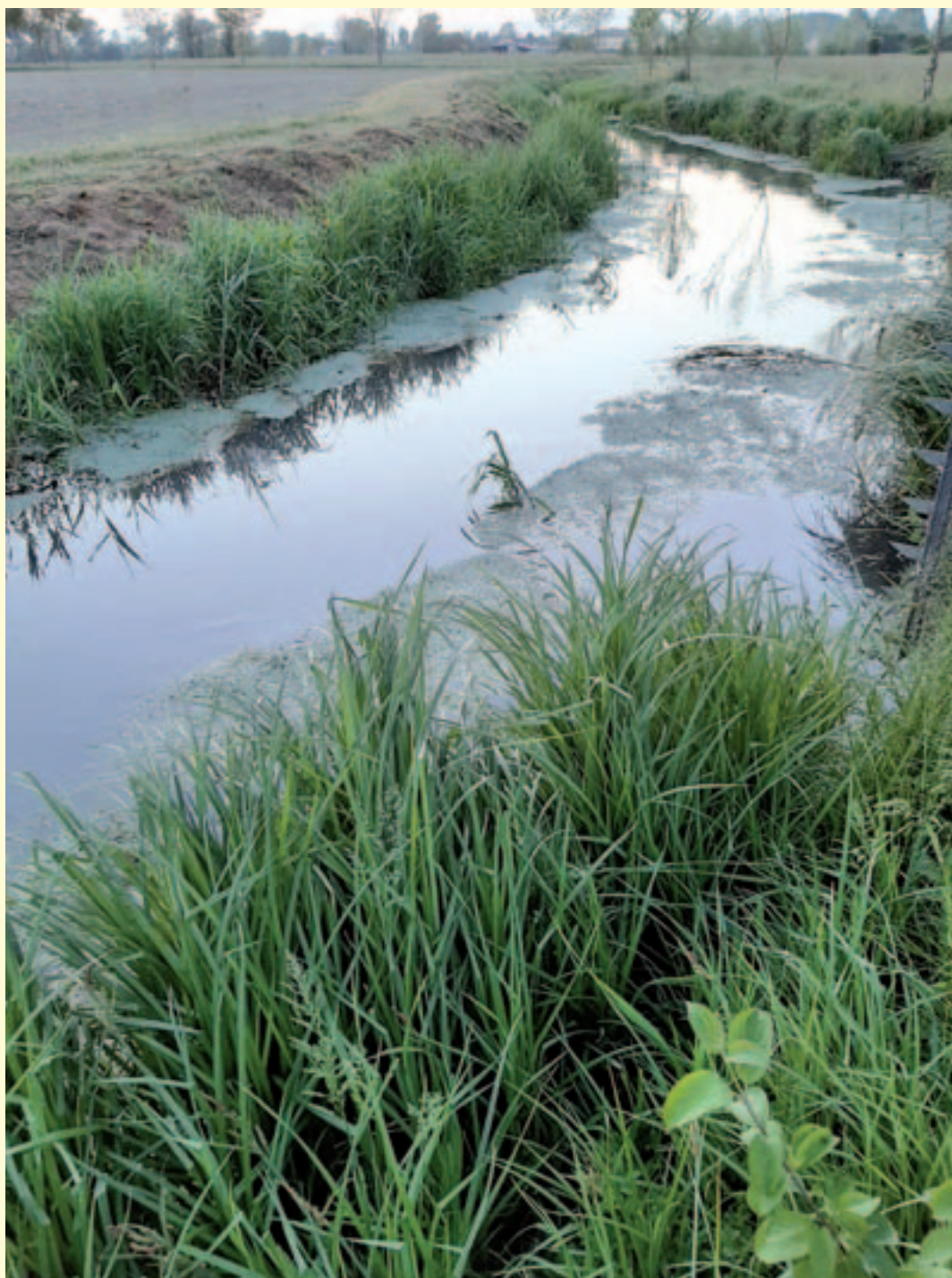
Figura 5.15 – Canale di corrente centrale creato mediante sfalcio parziale della vegetazione palustre. (Fonte: Consorzio di Bonifica Acque Risorgive – Muson Vecchio)
