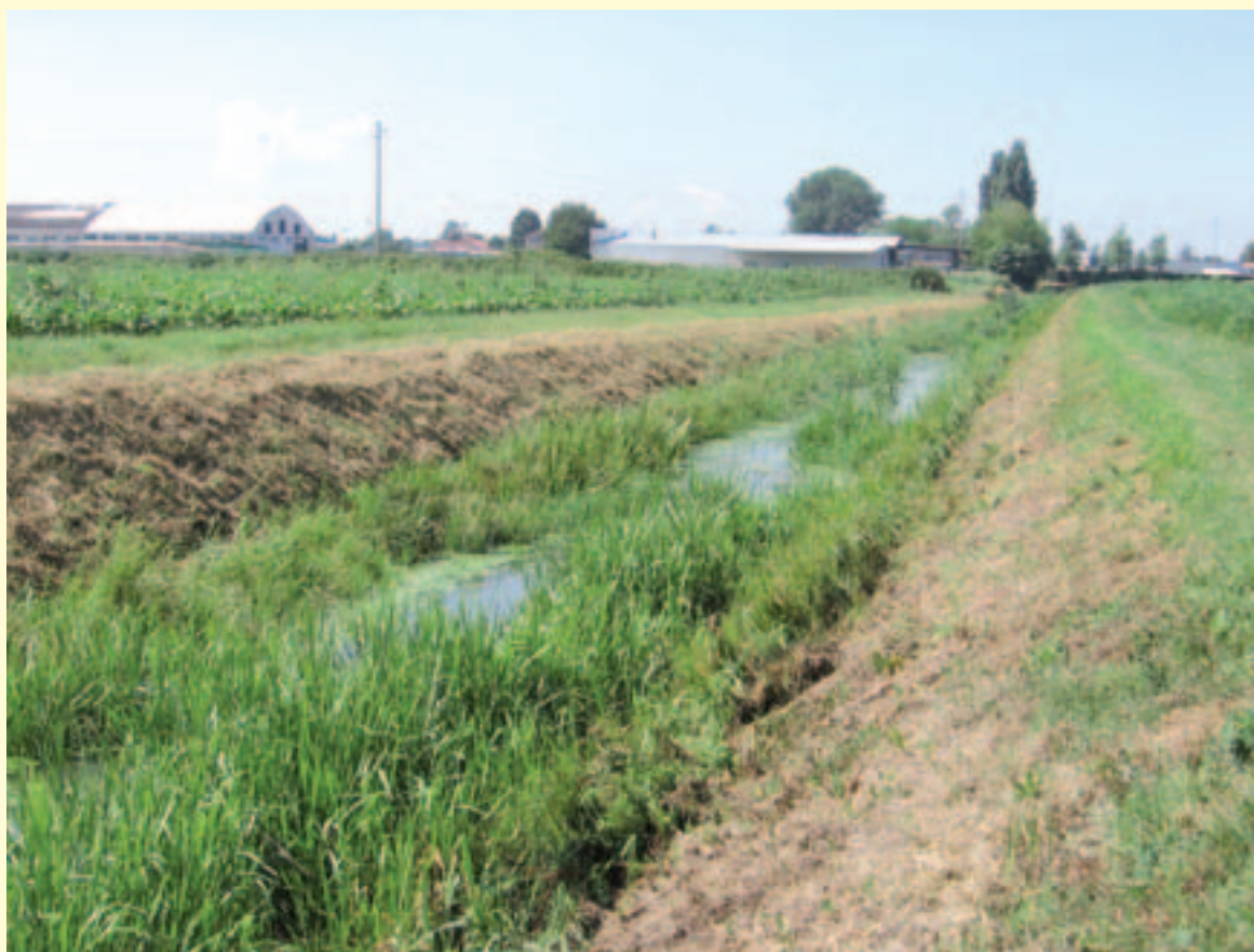
Figura 3.35 – Modalità di gestione della vegetazione in alveo funzionale a massimizzare i processi autodepurativi. La vegetazione palustre non è asportata totalmente, lasciando due strisce vegetate al piede della sponda. In questo modo le acque del canale possono attraversare, con velocità limitata, la zona vegetata e subire così i processi depurativi indotti da questo sistema fitodepurante naturale. (Fonte: Consorzio di Bonifica Acque Risorgive).
