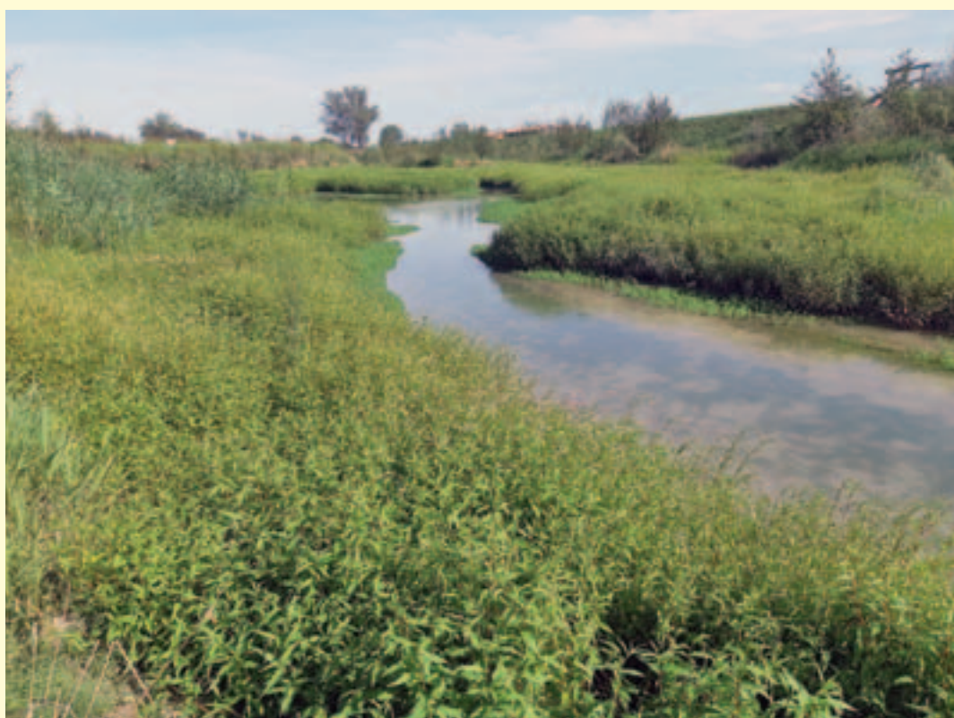
Figura 1.9 – Allargamento di sezione dello Scolo Zeretto e creazione di golene allagabili colonizzate da vegetazione palustre. Nelle due immagini è possibile vedere il canale allargato e l’inizio della colonizzazione da parte della vegetazione palustre. L’argine originariamente rettilineo e posto a ridosso dell’alveo di magra è stato arretrato per creare le golene allagabili e l’alveo rettilineo è stato reso meandriforme all’interno delle nuove golene. (Fonte: Consorzio di Bonifica Acque Risorgive)
