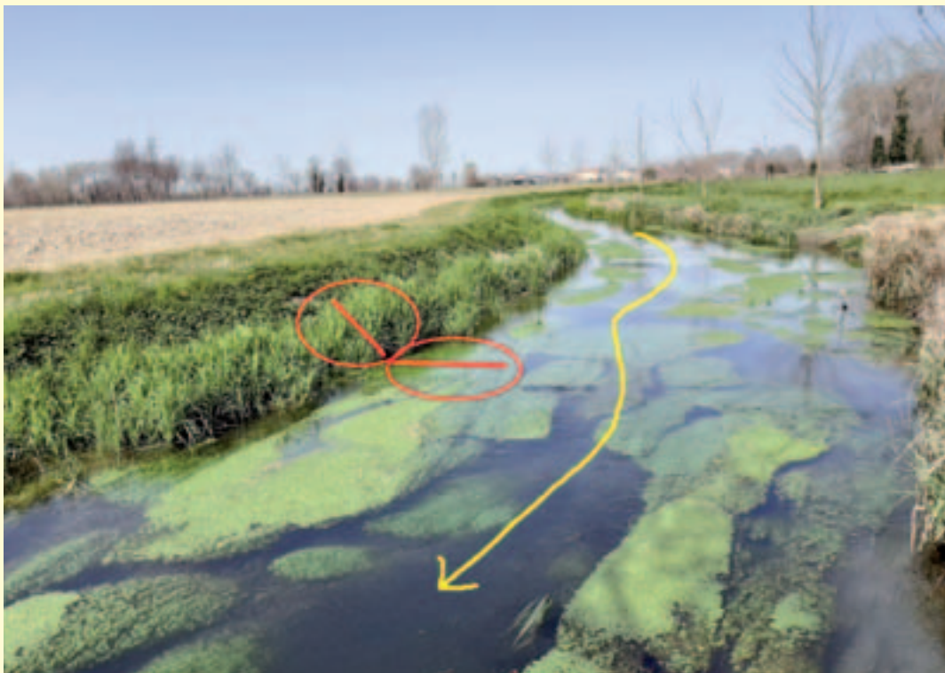
Figura 5.14 – Manutenzione della vegetazione acquatica presente sul fondo: in giallo si nota il canale di corrente ove la vegetazione è stata eliminata e, in rosso, la vegetazione acquatica e spondale lasciata a protezione della sponda in curva contro le erosioni e per preservare questo importante habitat di passaggio. (Fonte: Consorzio di Bonifica Acque Risorgive – Muson Vecchio)
