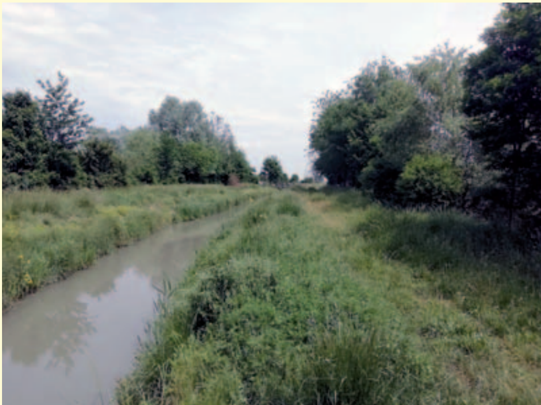
Figura 3.31 – Creazione di una zona umida fuori alveo con finalità depurative e di laminazione delle piene in Comune di Badia Polesine (Rovigo). Nelle immagini è possibile vedere una delle due zone umide realizzate e il canale Valdentro che le alimenta. (Fonte: Consorzio di Bonifica Adige Po)
