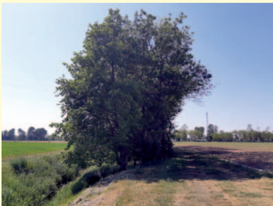
Figura 3.3 – Realizzazione di fasce forestali con effetto tampone lungo la Piovega di Scandolara, al fine di intercettare ed abbattere il carico di nutrienti veicolati dalla falda (N) e dall'erosione dei terreni (P). (Fonte: Consorzio di Bonifica Acque Risorgive)
