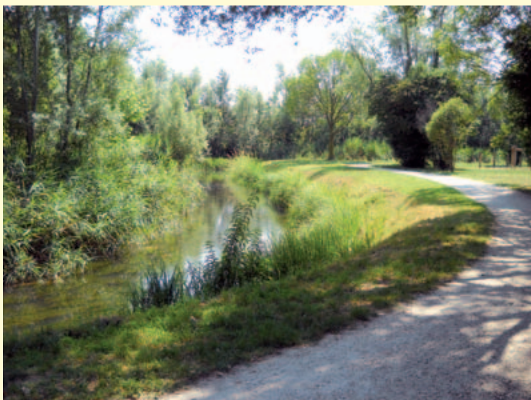
Figura 1.4 – Ampliamento di sezione lungo il Rio Draganzuolo mediante creazione di una golena allagabile. Nella serie di immagini è possibile vedere il canale allargato e le golene appena create al termine dei lavori e a seguire l’inizio della colonizzazione da parte della vegetazione palustre e riparia. (Fonte: Consorzio di Bonifica Acque Risorgive)
