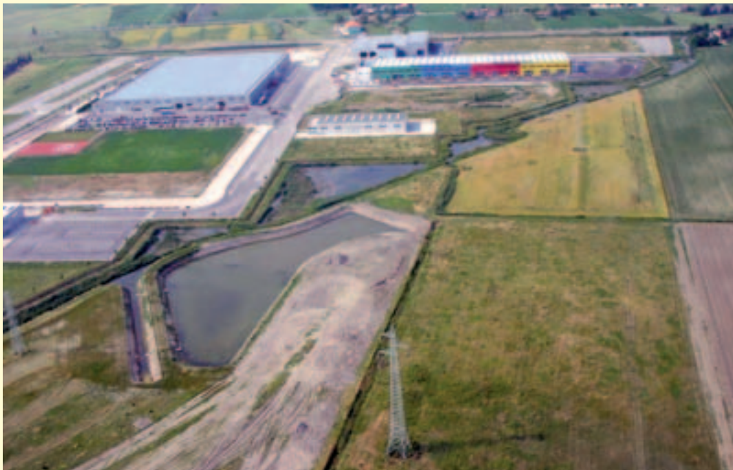
Figura 3.30 – Costruzione di una vasca di espansione a servizio di aree urbanizzate in Comune di Conselve. (Fonte: Consorzio di Bonifica Adige Euganeo)
