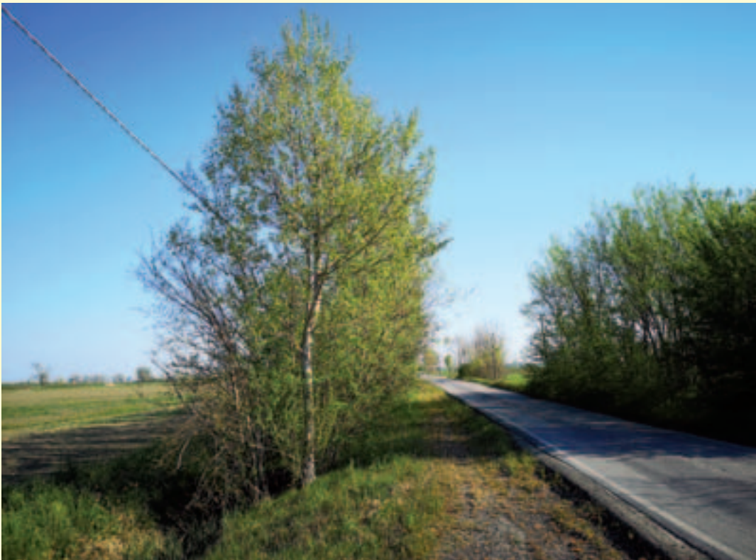
Figura 2.17 – Realizzazione di una palificata semplice rinverdita con palo frontale verticale lungo la Fossetta dei Morti (Comune di Carpi – Provincia di Modena). Nelle prime due foto è possibile vedere la fossetta prima dell'intervento (2004) e subito dopo la realizzazione della palificata (2004). Nelle successive due foto è mostrata la Fossetta dopo 5 anni dall'intervento (2009) e dopo 16 anni (2020). (Fonte: Consorzio di Bonifica dell'Emilia Centrale)
