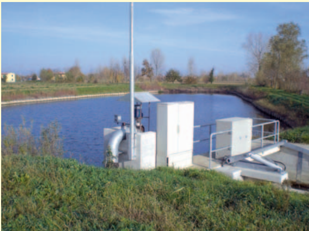
Figura 3.24 – Creazione di una vasca di espansione in località Candellara (Comune di Meolo) con finalità idrauliche e ambientali. (Fonte: Consorzio di Bonifica Piave)
