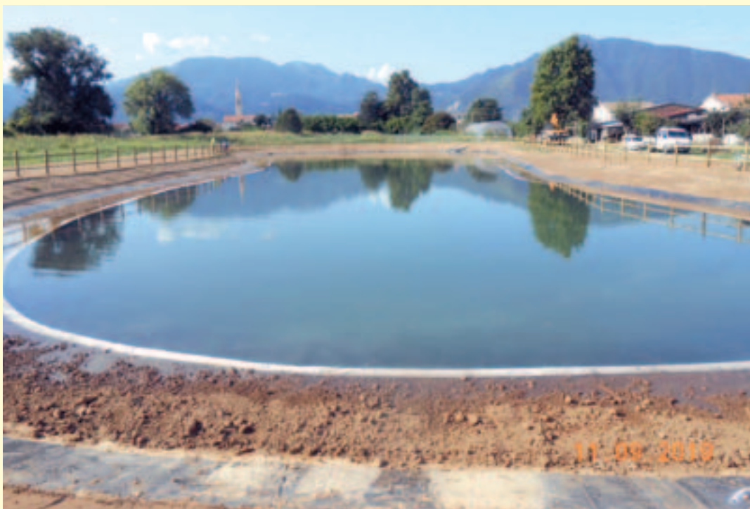
Figura 3.22 – Creazione di un bacino in ambito agricolo (water retention basin) per l'accumulo delle acque. Nelle immagini è possibile vedere il bacino in fase di costruzione e il particolare della banchina spondale su cui è stata messa a dimora la vegetazione palustre. (Fonte: Consorzio di Bonifica Alta Pianura Veneta).
