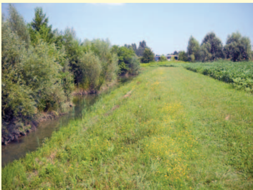
Figura 5.17 – Manutenzione gentile della vegetazione di sponda lungo il Fiume Zero; operazioni eseguite solo su una sponda, lasciando sull'altra la presenza di arbusti. (Fonte: Consorzio di Bonifica Acque Risorgive)
