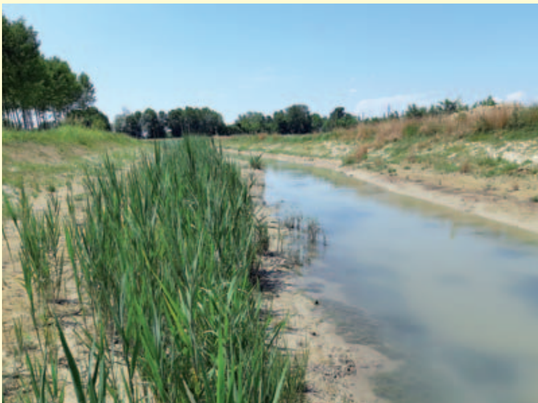
Figura 1.7 – Allargamento di sezione dello Scolo Vernise e creazione di banchine allagabili colonizzate da vegetazione palustre. Nelle due immagini è possibile vedere il canale allargato al termine dei lavori, con l'argine originariamente posto a ridosso dell'alveo di magra ora arretrato per creare la banchina allagabile, e l'inizio della colonizzazione da parte della vegetazione palustre. (Fonte: Consorzio di Bonifica Acque Risorgive)
