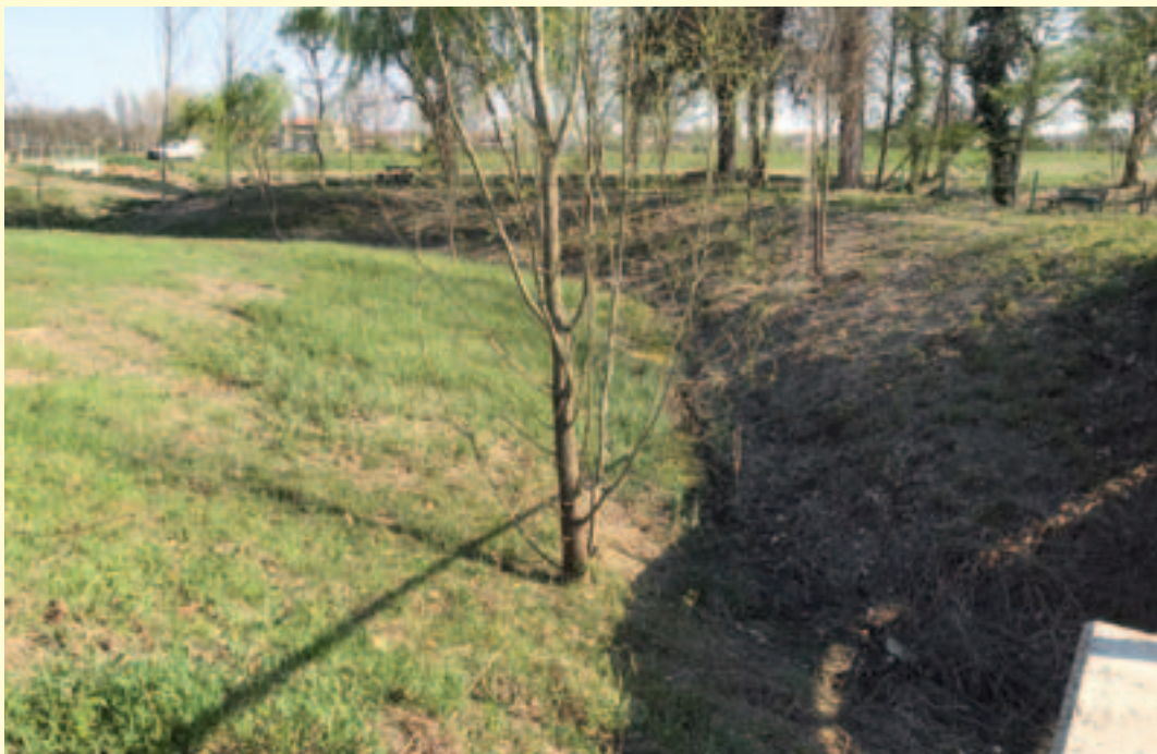
Figura 3.25– Costruzione nell'area del Mulino Daiol di un canale meandriforme con la funzione di invaso per l'aumento della capacità autodepurativa del sistema di canali afferenti. Nelle immagini è possibile vedere lo schema di progetto del canale e il canale meandriforme a distanza di qualche tempo dalla realizzazione. (Fonte: Consorzio di Bonifica Piave)
