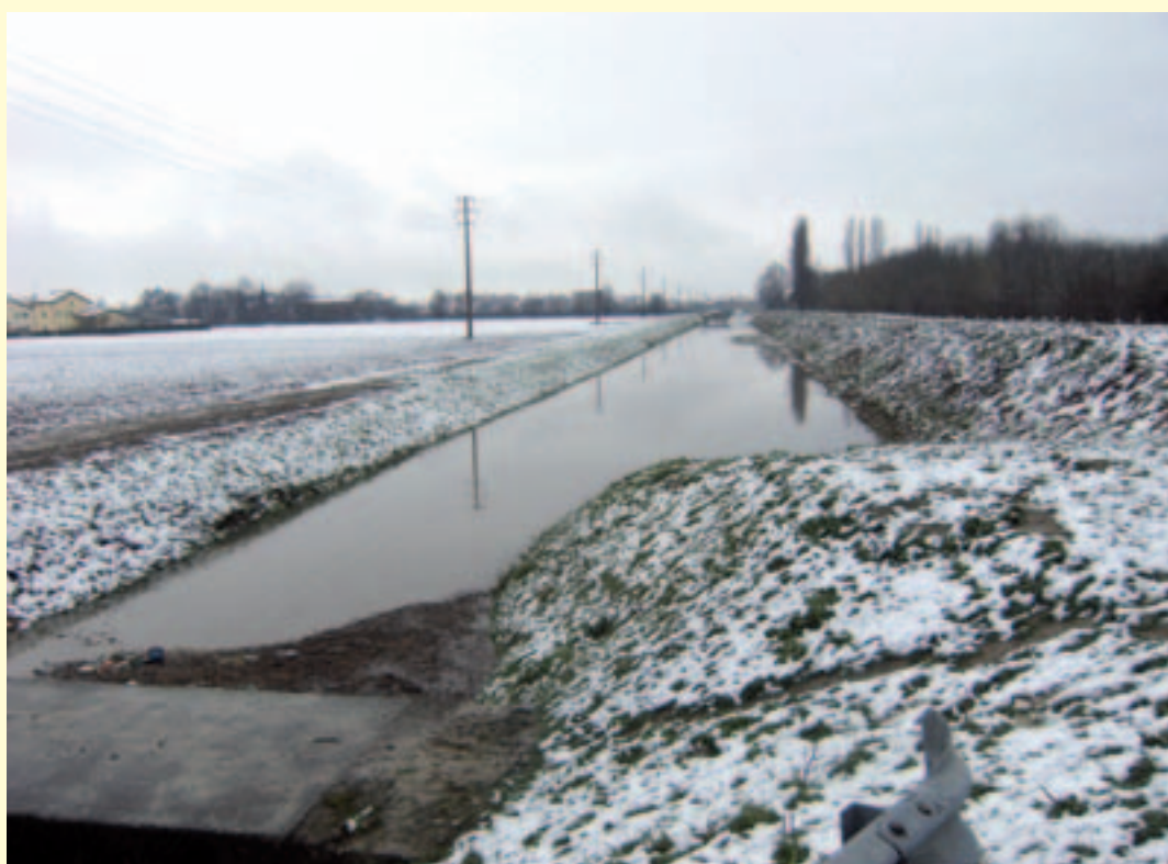
Figura 1.24 – Creazione di una banchina interna allagabile lungo il Diversivo Fossa Nuova Cavata (Comune di Carpi – Provincia di Modena). Nelle immagini è possibile vedere: il canale prima dell'intervento (2015); lo schema progettuale, che prevede il tombamento del Condotto irriguo Gusmea al fine di permettere lo scavo della banchina allagabile; la banchina dopo 4 anni dall'intervento (2020), con la vegetazione pioniera che inizia a colonizzare l'area; un evento di piena che evidenzia l'invaso della banchina, a confronto con la sponda opposta non riprofilata. (Fonte: Consorzio di Bonifica dell'Emilia Centrale)
