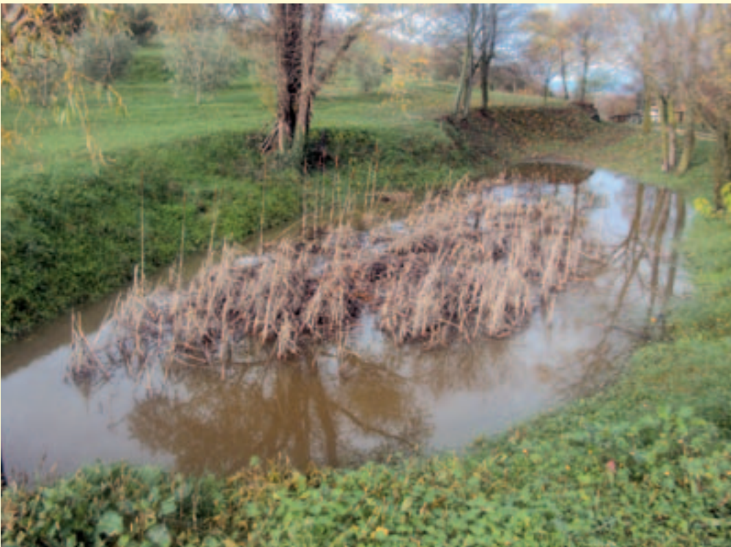
Figura 3.21 – Creazione di un micro bacino di laminazione. Nell'immagine è possibile vedere il bacino colonizzato da vegetazione palustre subito dopo l'esecuzione dei lavori e lo stato attuale del bacino a distanza da alcuni anni dalla realizzazione del progetto. (Fonte: Consorzio di Bonifica Alta Pianura Veneta)
