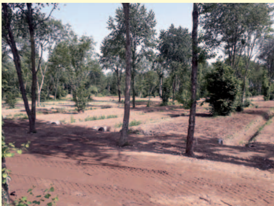
Figura 4.15 – Realizzazione di AFI (Aree di Infiltrazione Forestale) nel Comune di Rosà. (Fonte: Consorzio di Bonifica Brenta)
