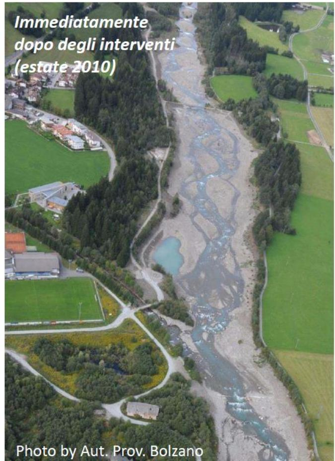
*Rio Mareta (BZ) prima e dopo gli interventi di riqualificazione fluviale di ampliamento dell'alveo e rimozione delle briglie*
