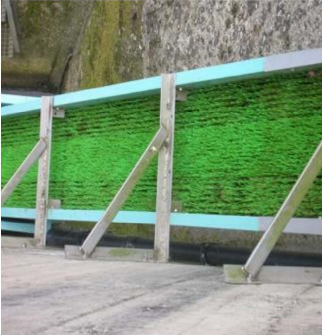
Substrato artificiale con setole in nylon disposto verticalmente.
