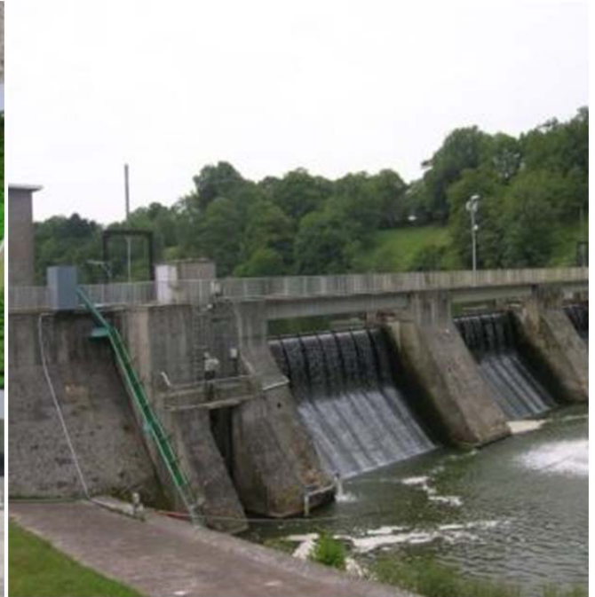
Disposizione dell'impianto di risalita per anguille a lato di uno sbarramento artificiale.
