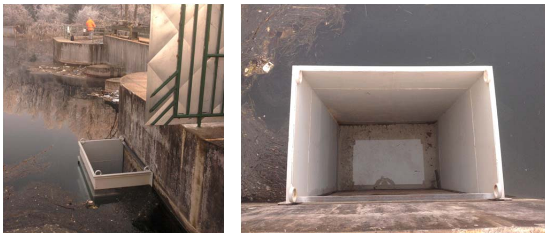
Esempio di impiego di cassone a tenuta per esecuzione foro
