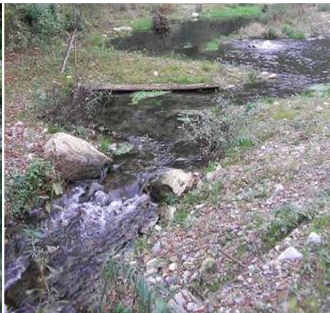
Diversivo Torrente Breggia Chiasso – Svizzera.
