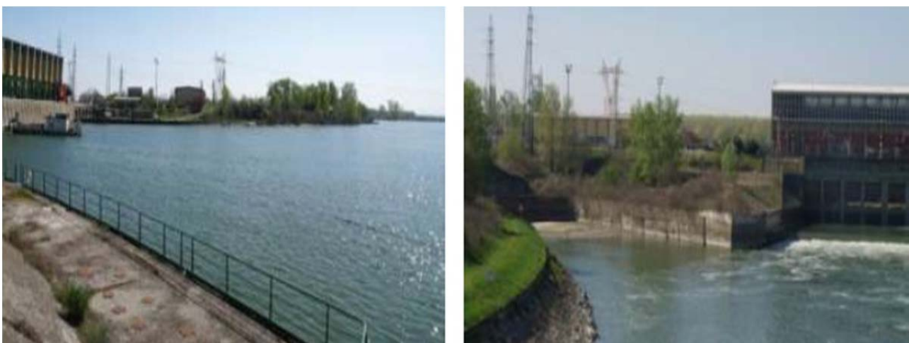
A sinistra vista sponda a monte dello sbarramento mentre a destra vista di valle.
