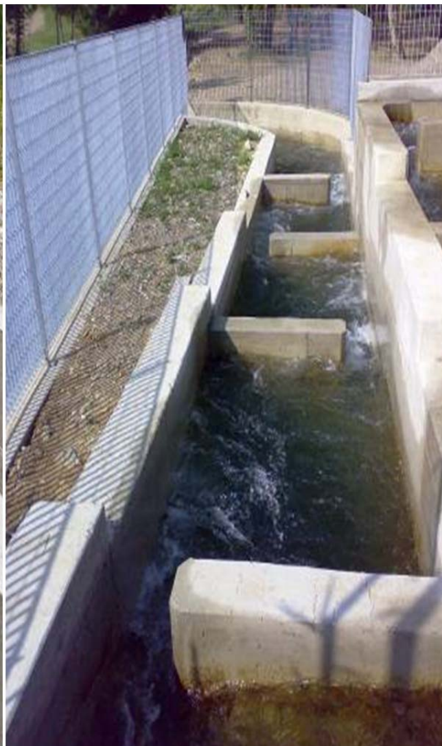
Passaggio sul Fiume Oglio in Provincia di Bergamo.
