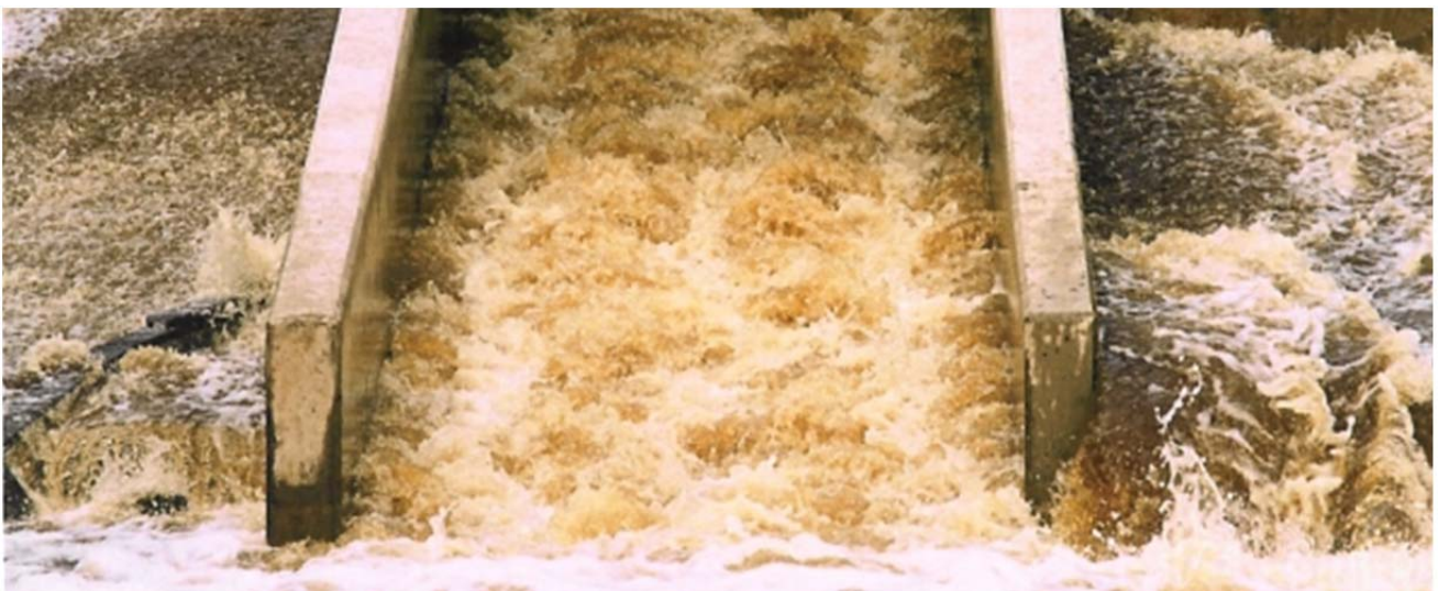
Passaggio utilizzato sia per la risalita dei pesci che per la discesa di kayak.
