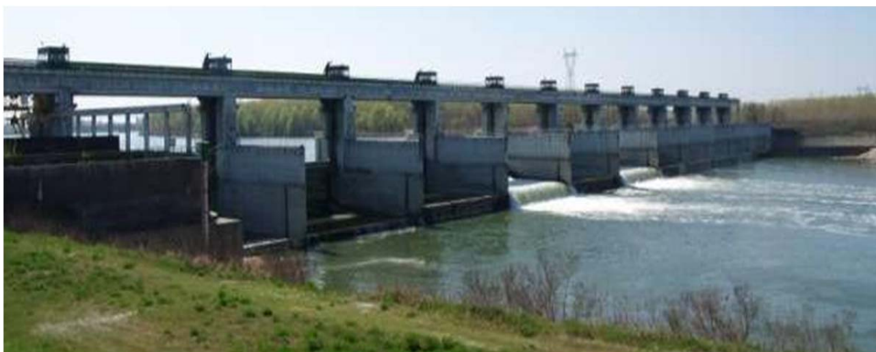
Vista di valle dello sbarramento di Isola Serafini sul ramo naturale del Fiume Po. In primo piano sponda destra idrografica e sullo sfondo sponda sinistra idrografica.
