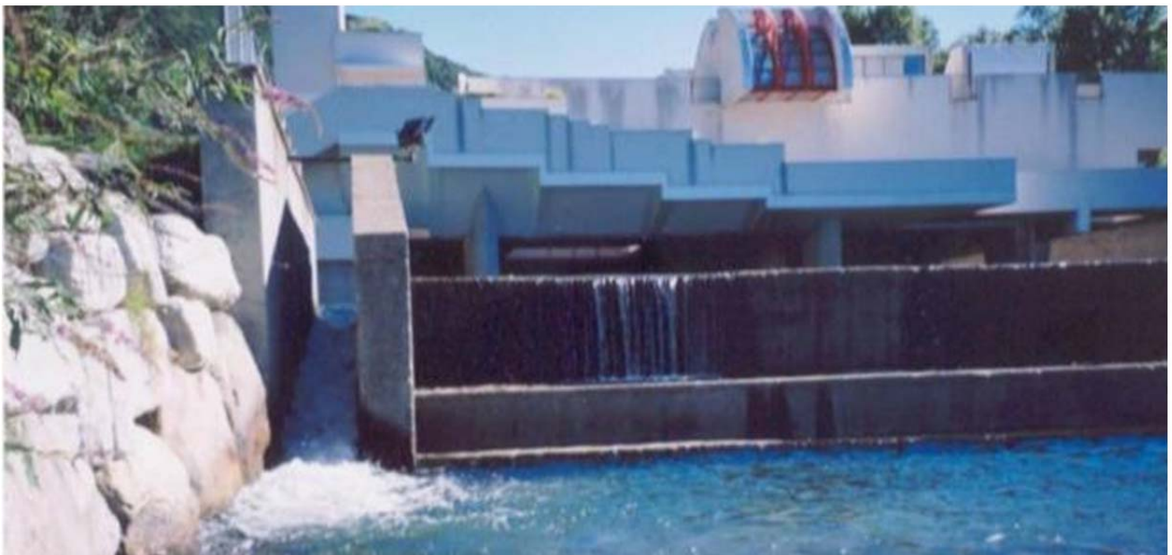
Passaggio per pesci di tipo Denil sul Torrente Giona in Provincia di Varese.
