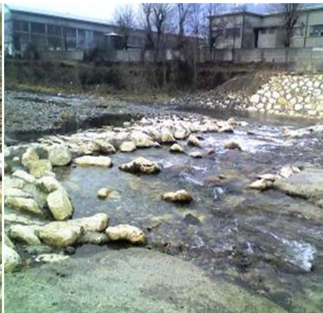
Rampa sul Fiume Serio in Provincia di Bergamo.
