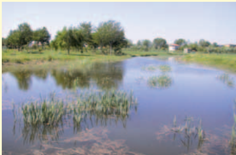
Figura 1.2 – Ampliamento di sezione lungo la Fossa Pagana: l'alveo, originariamente rivestito da muri in calcestruzzo (foto in alto), è stato allargato allo scopo di creare ampie golene allagabili utili a diminuire le esondazioni nel territorio posto a valle (foto centrale), golene che sono state successivamente colonizzate da vegetazione acquatica (foto in basso). (Fonte: Consorzio di bonifica Acque Risorgive).
