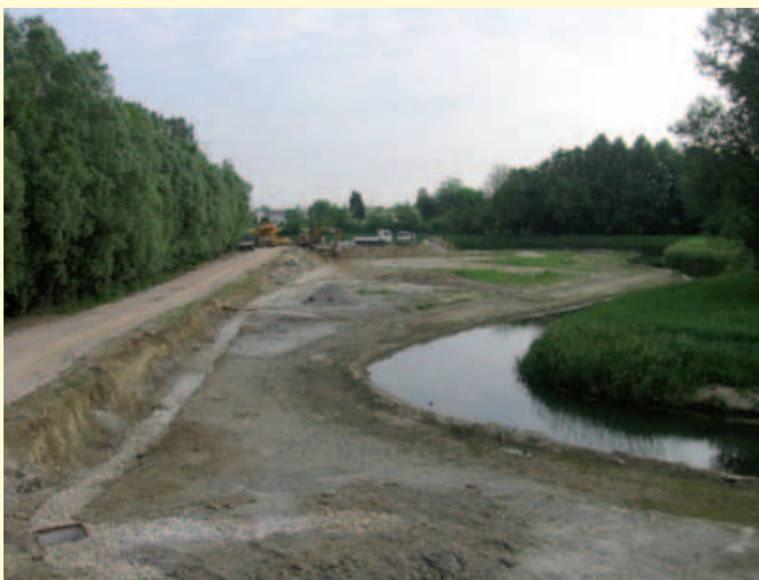
Figura 1.3 – Ampliamento di sezione lungo il Rio Draganziolo mediante sbancamento di una sponda, così da creare una golena allagabile e adatta alla colonizzazione da parte di vegetazione arboreo-arbustiva e acquatica (foto in basso: l'intervento a fine lavori); le acque defluiscono di norma lungo un canale di magra (a destra nella foto in basso), mentre in caso di piena occupano l'intera sezione del canale e vengono così rallentate nel deflusso verso valle. (Fonte: Consorzio di bonifica Acque Risorgive).
