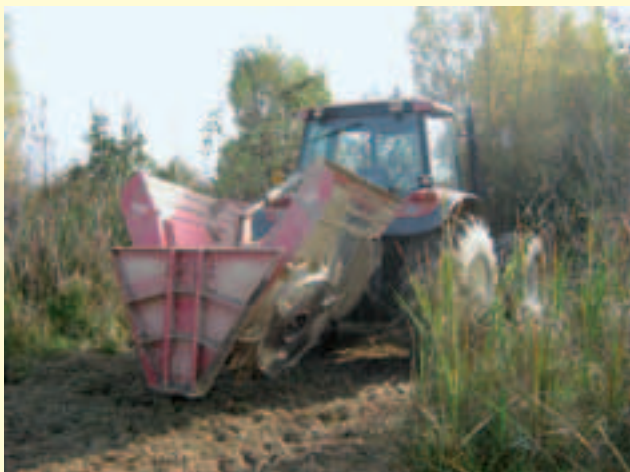
Figura 3.5 – Ripristino del canale di carico attraverso l'uso di uno scavafossi. (Foto: Paolo Giacobbi).
