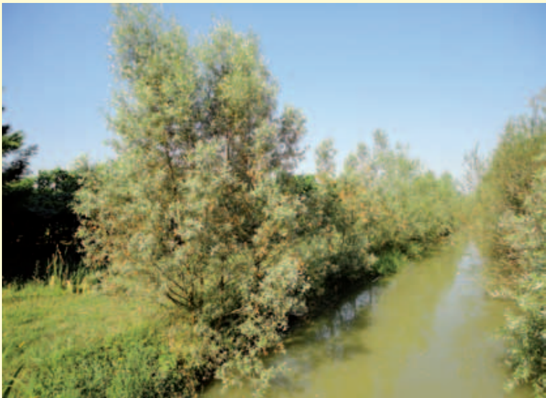
Figura 2.9 – In alto: palizzata a fine lavori, viva nella parte sommitale (picchetti di salice) e morta al piede di sponda (picchetti morti di castagno). In basso: l'intervento dopo 5 anni (Canale di Budrione – Provincia di Modena), ove si nota la fascia riparia a salici sviluppatasi in seguito alla realizzazione della palizzata viva. (Fonte: Consorzio di bonifica dell'Emilia centrale, 2005) (Foto: Marco Monaci).
