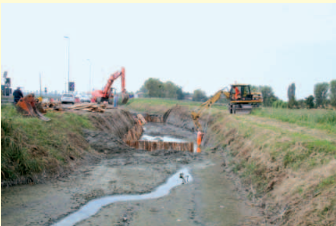
Figura 3.14 – Trappola per sedimenti in fase di costruzione lungo il Canale di San Giovanni, al termine dei lavori di abbassamento del fondo alveo (2009). Si noti in primo piano e sullo sfondo, prima e dopo lo scavo, il livello del fondo del canale, superiore a quello presente all'interno della trappola. Il perimetro dello scavo è protetto, nel caso in esame, da paleria di castagno, per evitare il franamento delle pareti della trappola. (Fonte: Consorzio di bonifica pianura di Ferrara, 2008). (Foto: Marco Monaci).
