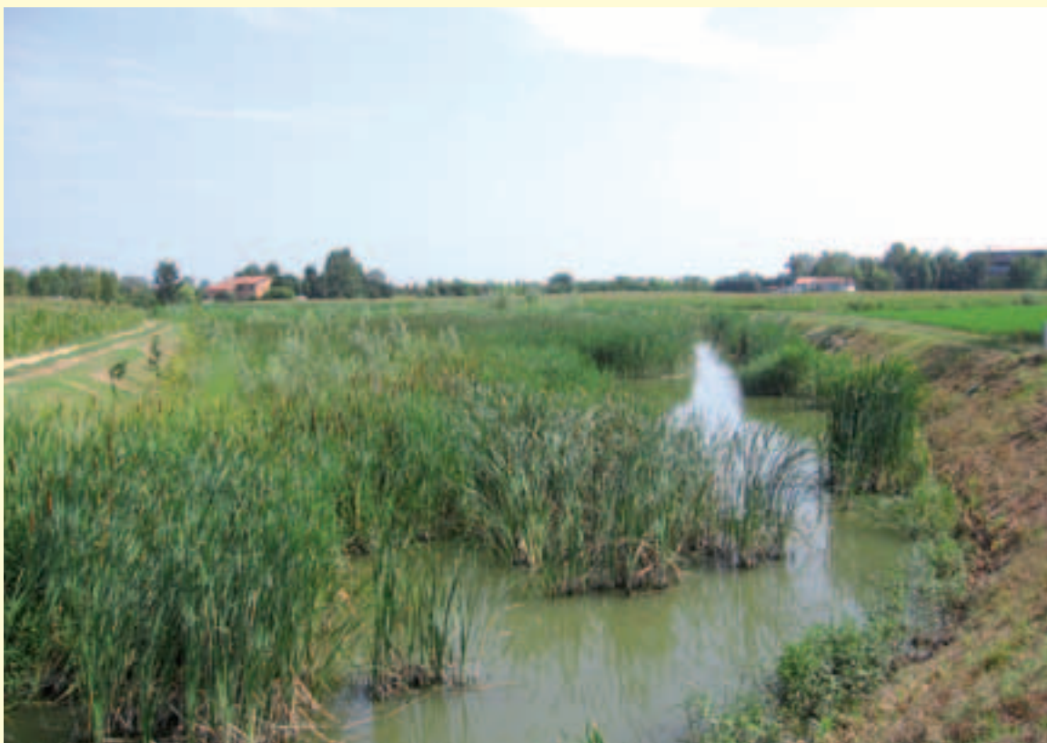
Figura 3.9 – Costruzione di una zona umida in alveo lungo la Fossa Pagana. In alto: il canale prima della realizzazione degli interventi di riqualificazione. In basso: allargamento e rimodellamento della sezione al fine di costruire la zona umida in alveo. (Fonte: Consorzio di bonifica Acque Risorgive).
