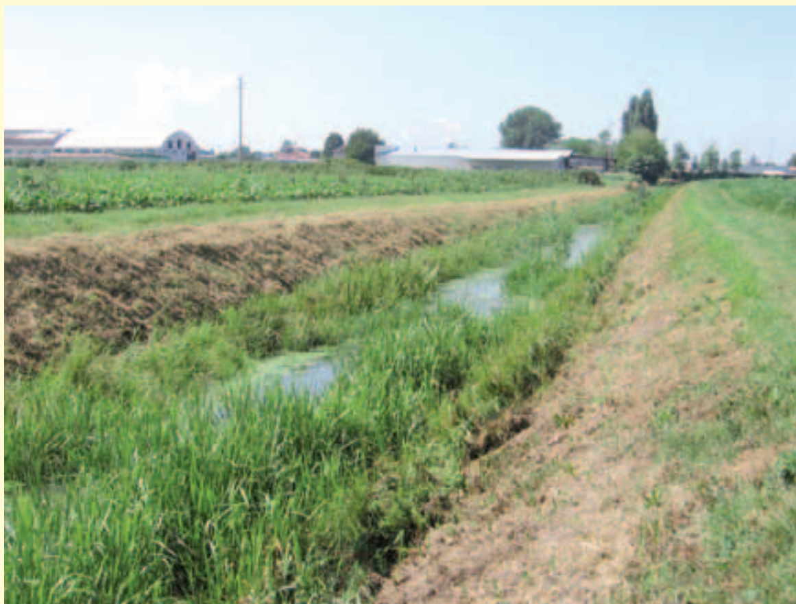
Figura 3.15 – Modalità di gestione della vegetazione in alveo funzionale a massimizzare i processi autodepurativi. La vegetazione palustre non è asportata totalmente, lasciando due strisce vegetate al piede della sponda. In questo modo le acque del canale possono attraversare, con velocità limitata, la zona vegetata e subire così i processi depurativi indotti da questo sistema fitodepurante naturale. (Fonte: Consorzio di bonifica Acque Risorgive).
