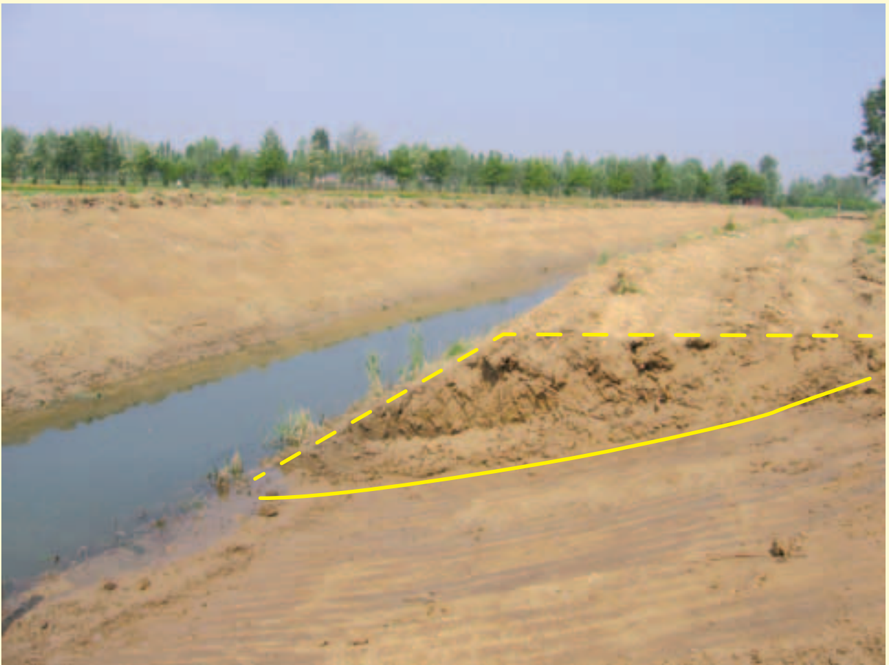
Figura 2.3 – Riduzione della pendenza delle sponde; la linea gialla tratteggiata indica il profilo precedente della scarpata spondale, mentre quella gialla continua il profilo a fine lavori. (Fonte: Consorzio di bonifica Acque Risorgive).
