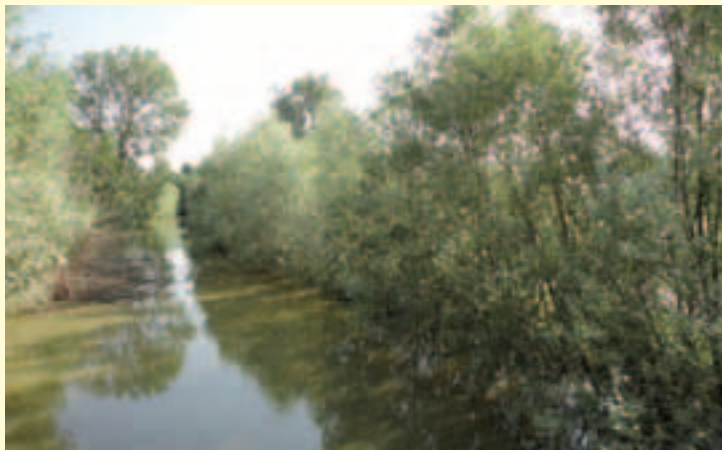
Figura 2.7 – In alto: la sponda destra del canale è soggetta a problemi di dissesto. Al centro: posa degli astoni di salice sulla sponda destra. In basso: la sponda, protetta mediante copertura diffusa con astoni di salice, si presenta vegetata a 5 anni dalla fine dei lavori. La vegetazione ha attecchito solo nella parte sommitale della copertura, mentre lunghi periodi di riempimento del canale a scopi irrigui (come quello mostrato in figura), inizialmente non programmati né prevedibili dal Consorzio ai tempi della predisposizione del progetto, non hanno permesso alla vegetazione di attecchire nella parte più prossima all'acqua (Canale di Migliarina - Provincia di Modena). (Consorzio di bonifica dell'Emilia centrale, 2005). (Foto: Marco Monaci).
