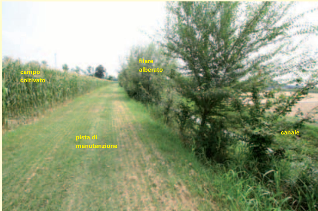
Figura 4.4 – Filare arboreo-arbustivo con finalità naturalistiche posto sulla sponda subito a ridosso del ciglio: la pista di manutenzione rimane transitabile e la vegetazione non interferisce con la funzionalità idraulica del canale (Fonte: Consorzio di bonifica Acque Risorgive). (Foto: Bruno Boz).
