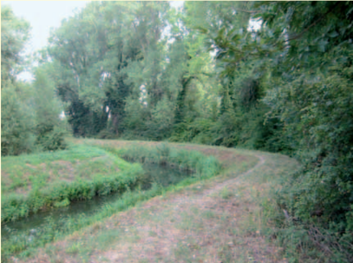
Figura 4.12 – Esempio di filare arboreo-arbustivo realizzato esternamente alla pista di manutenzione del canale. (Consorzio di bonifica Acque Risorgive).
