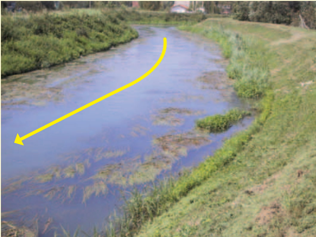
Figura 5.4 – Manutenzione della vegetazione acquatica presente sul fondo: in giallo si nota il canale di corrente ove la vegetazione è stata eliminata e, sulla destra della foto, la vegetazione acquatica lasciata a protezione della sponda in curva contro le erosioni. (Fonte: Consorzio di bonifica Acque Risorgive).
