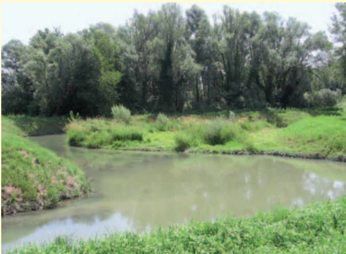
Figura 3.7 – Creazione di aree golenali colonizzate da vegetazione palustre. (Fonte: Consorzio di bonifica Acque Risorgive).
