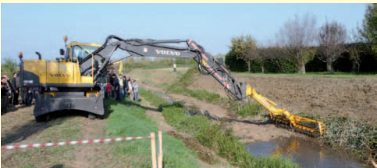
Figura 5.11 – Benna falciante dotata di “prolunga” (Fonte: Consorzio di bonifica Acque Risorgive).
