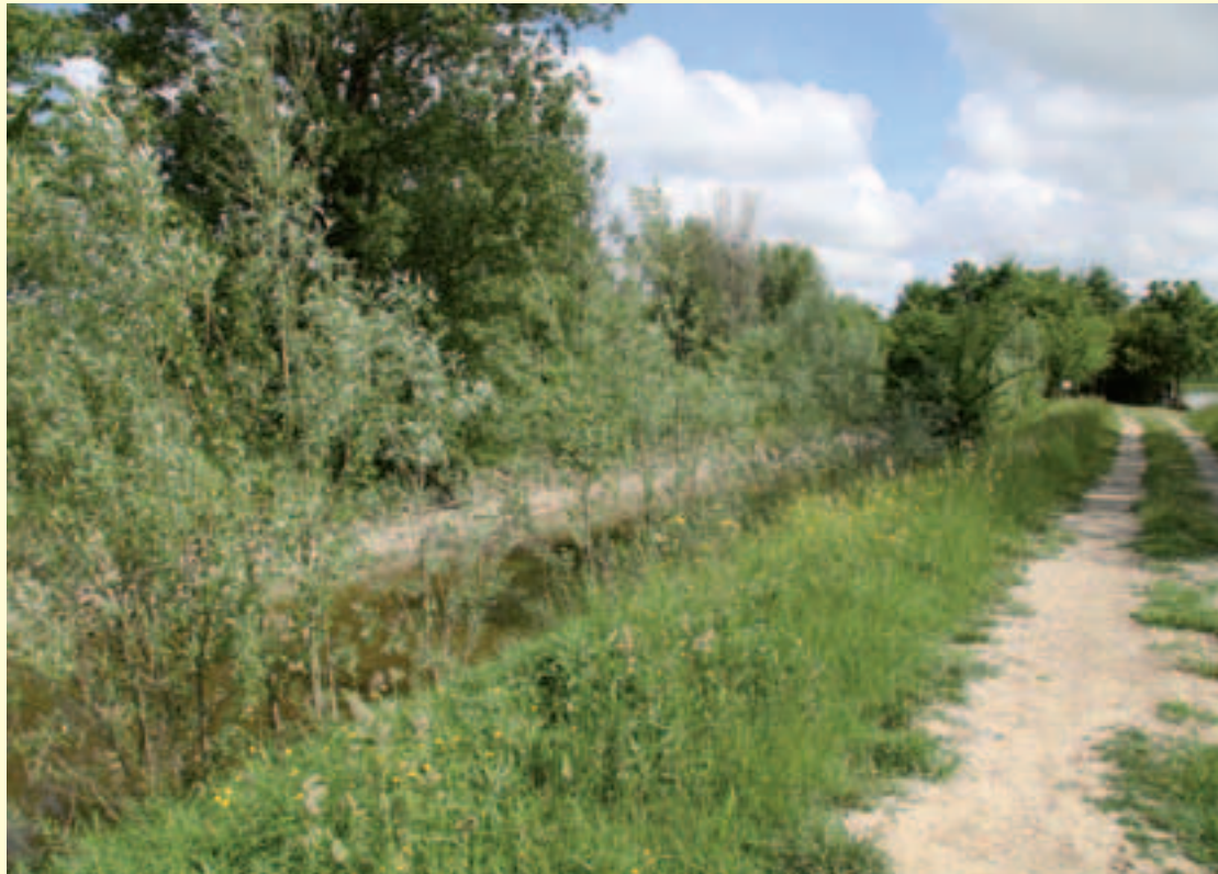
Figura 4.5 – Filare arboreo-arbustivo posto sul ciglio di entrambe le sponde di un canale; la pista di manutenzione rimane transitabile e la manutenzione dell'alveo del canale è effettuata con cadenza pluriennale. (Consorzio di bonifica Emilia Centrale) (Foto: Marco Monaci).
