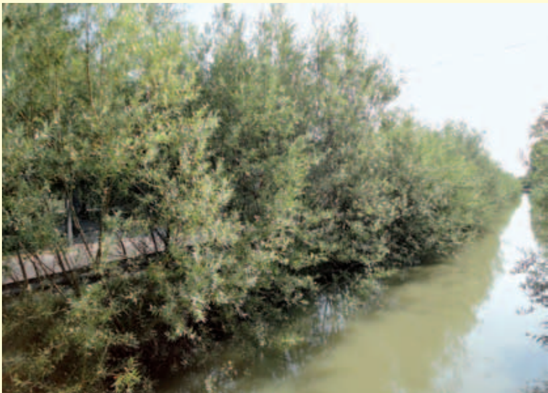
Figura 2.11 – In alto: palificata semplice rinverdita con palo frontale realizzata lungo un canale onde evitare dissesti in corrispondenza di una strada. L'intervento è stato poi completato mediante messa a dimora di astoni di salice sulla sommità dell'opera, così da creare una fascia riparia seppur semplificata. In basso: l'intervento dopo 4 anni (Canale di Budrione – Provincia di Modena), ove si nota la fascia riparia a salici sviluppatasi in seguito alla realizzazione della palificata viva. (Fonte: Consorzio di bonifica dell'Emilia centrale, 2005). (Foto: Marco Monaci).
