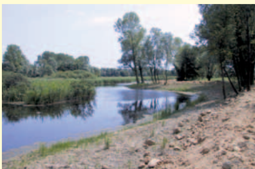
Figura 1.7 – Creazione ex-novo di un canale naturaliforme su terreno agricolo. In alto, l'area rurale prima dell'intervento (settembre 2003); al centro, scavo del canale sinuoso appena terminato (ottobre 2003); in basso, il canale naturaliforme colonizzato da vegetazione acquatica (agosto 2004). (Consorzio di bonifica Acque Risorgive).
