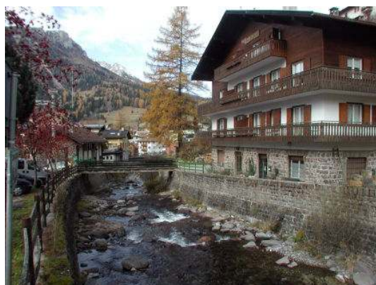
Figura 5. Rio S. Pellegrino a Moena: alveo confinato all'interno di aree densamente urbanizzate.
