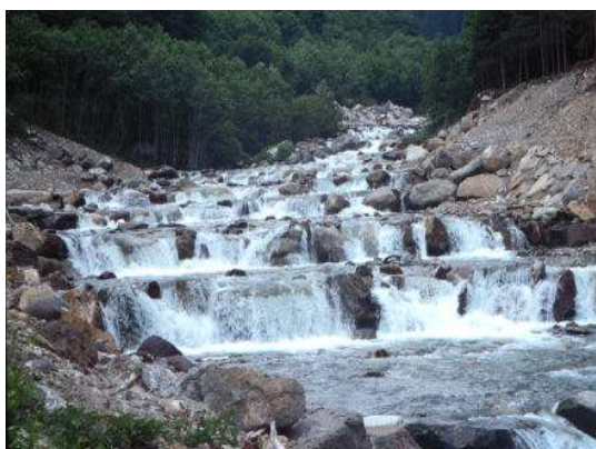
Figura 4. Torrente Maso: intervento di consolidamento in massi a secco con criteri di ricostruzione morfologica.
