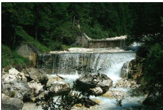
Figure 6 e 7 Val Canali – Trentino orientale: intervento di riqualificazione ambientale nel Parco Naturale Paneveggio e Pale di S. Martino con mascheramento completo di due briglie tradizionali in calcestruzzo, fortemente danneggiate, mediante una struttura in massi cementati posizionati con criteri di ricostruzione morfologica.
