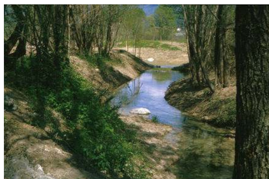
Figura 3. Rio Vena (Levico Terme), intervento di ripristino della sezione di deflusso in una bellissima rogga di fondovalle alimentata da risorgive.
