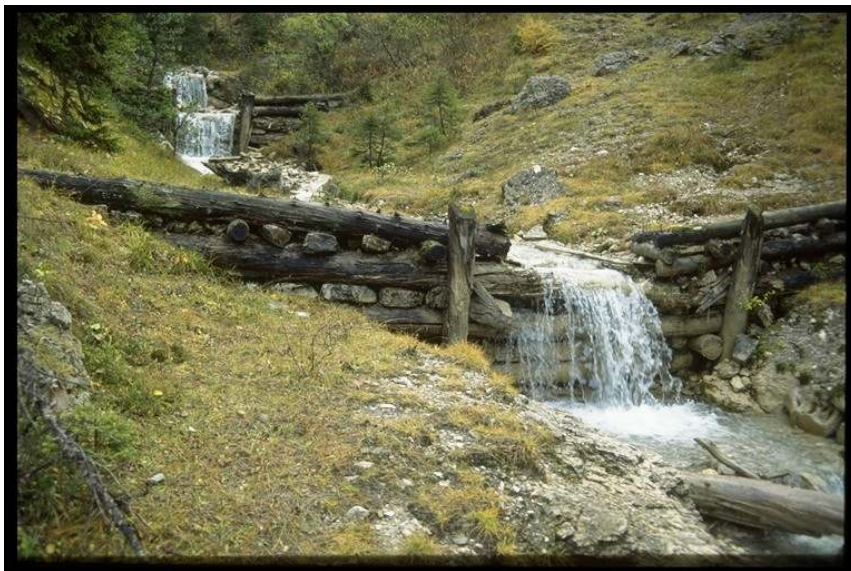
Fig. 18 - Antiche briglie di larice lungo il Rio Funes (Bolzano).
