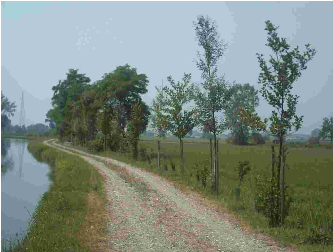
Figura 6.1: le strade alzaie dei canali con fondo in pietrisco sono già un ottimo punto di partenza per la realizzazione di un percorso verde. Nelle aree più “naturali” si manterrà inalterata la copertura della strada, adatta alla maggior parte delle utenze.
