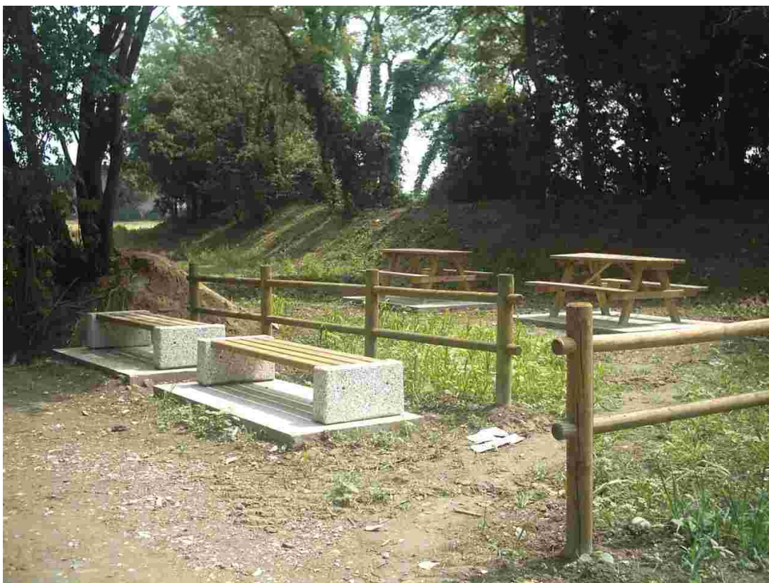
Figura 6.2: area attrezzata (in costruzione) per la sosta con panchine, tavoli, staccionate di delimitazione.
