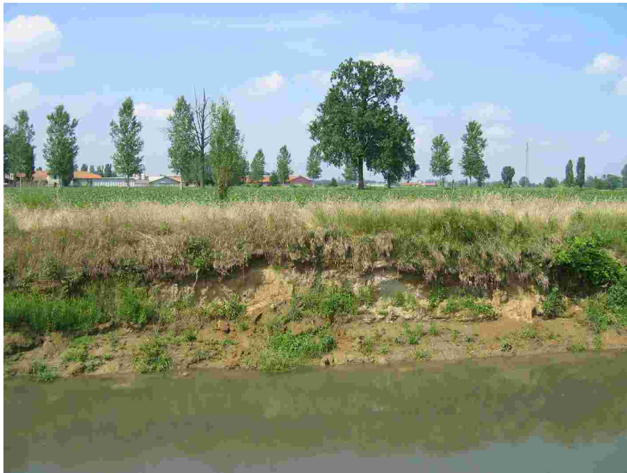
Figura A.12: cedimento di sponda.
