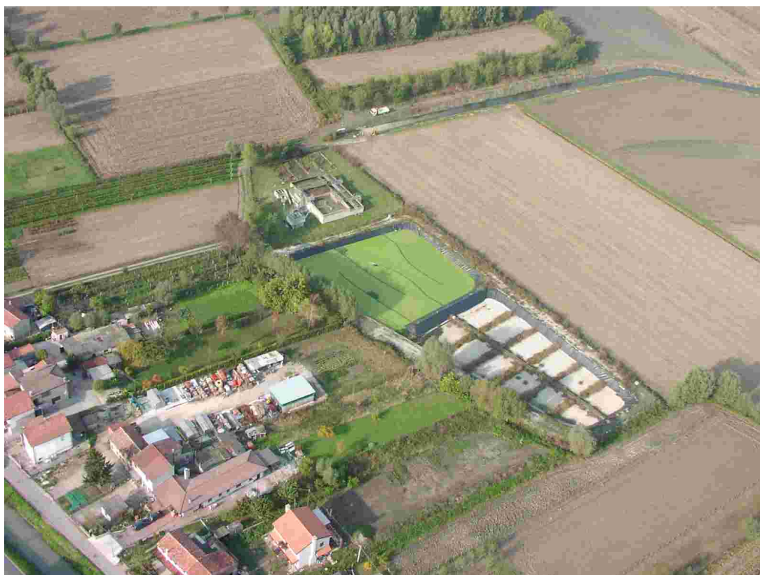
Figura 5.16: impianto di depurazione del comune di Villadose – Rovigo (foto C.B. Polesine Adige Canalbianco – Rovigo).
