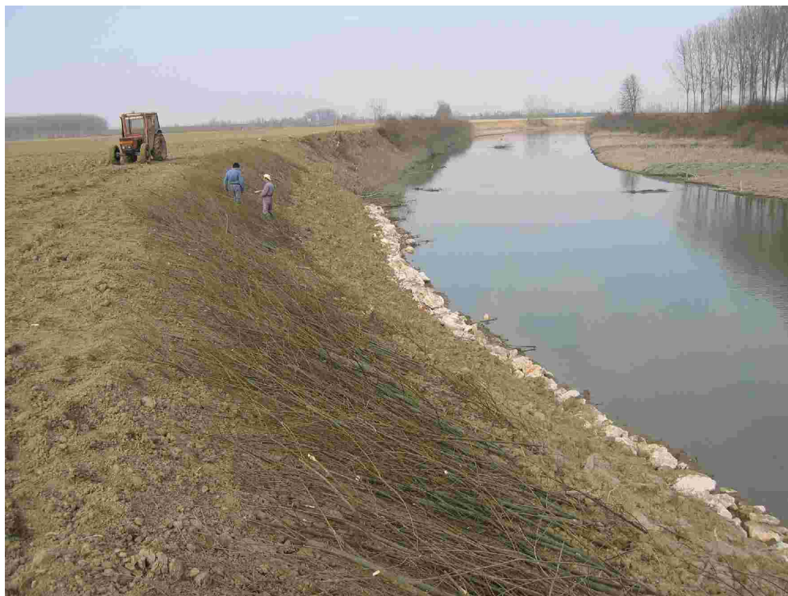
Figura 5.11: copertura diffusa con astoni (fiume Oglio, marzo 2005). Si noti il rinforzo del piede della sponda con massiciata e la copertura degli astoni con terra.
