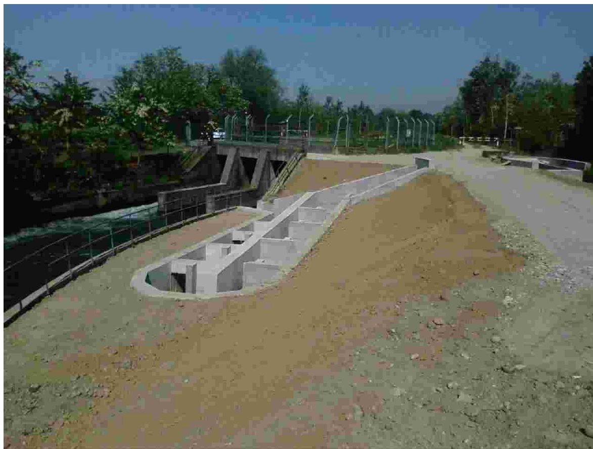
Figura 5.7: passaggio a bacini successivi sul canale Muzza all'altezza del terminale di Tripoli (foto Cremascoli, CBI Muzza Bassa Lodigiana).
