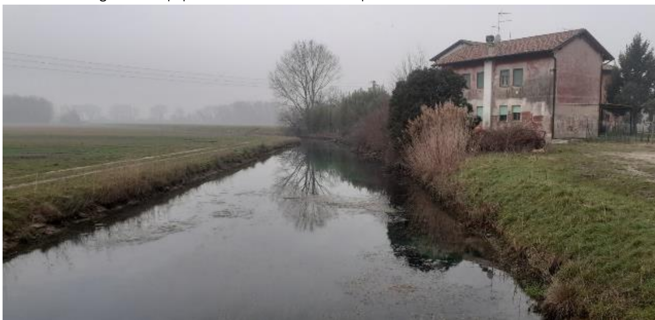
Figura 19 Corso d'acqua con banalizzazione dell'alveo e rimozione della vegetazione dalle sponde.
