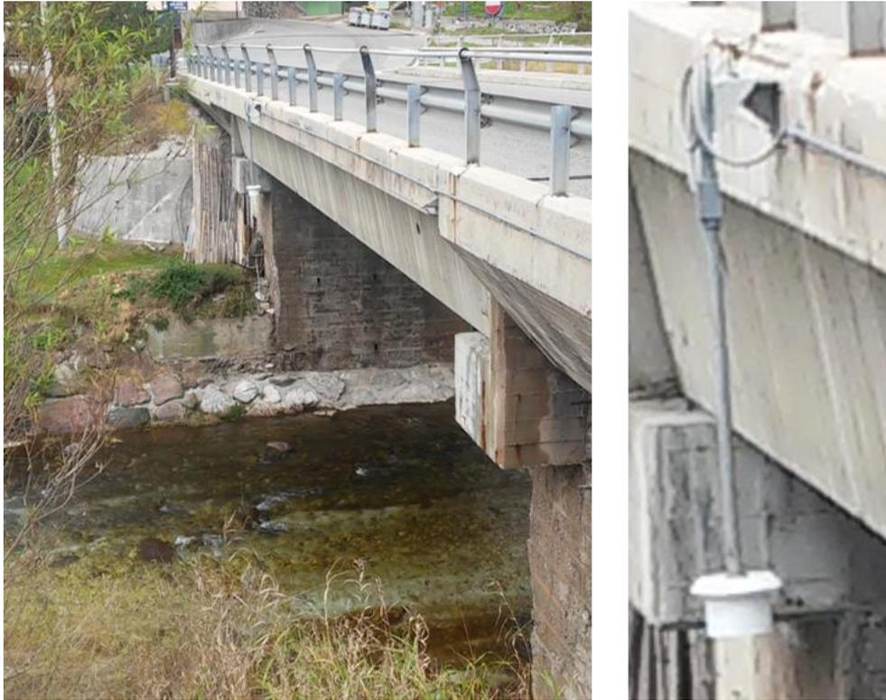
**Fig.4-37:** Idrometro ad ultrasuoni sul torrente Slizza della stazione di meteorologica di Tarvisio – Campo sportivo.
