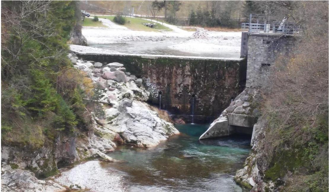
**Fig.2-15:** Briglia di sbarramento di 7 m, canale di restituzione e passaggio per pesci di tipo *fish ramp* asciutto in corrispondenza della derivazione ID:497 alimentante l'impianto di "Plezzut nuova 3" lungo il Torrente Slizza.
