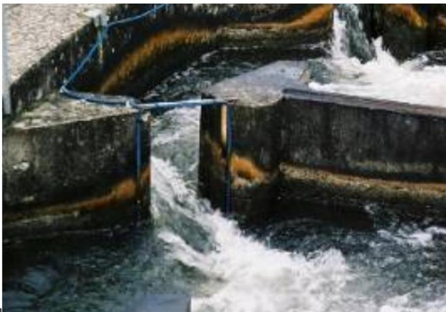
**Fig.8-39:** Esempio di installazione di antenna per pit-tag fenditura verticale di un passaggio tecnico (da Regione Piemonte, 2011)
