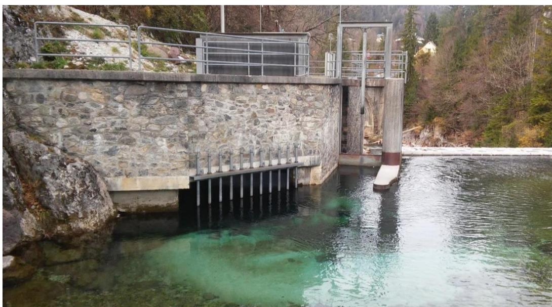
**Fig.2-18:** Bocca di presa dotata di griglia e paratoia di scarico su corpo briglia in corrispondenza della derivazione ID:497 alimentante l'impianto di "Plezzut nuova 3" lungo il Torrente Slizza.
