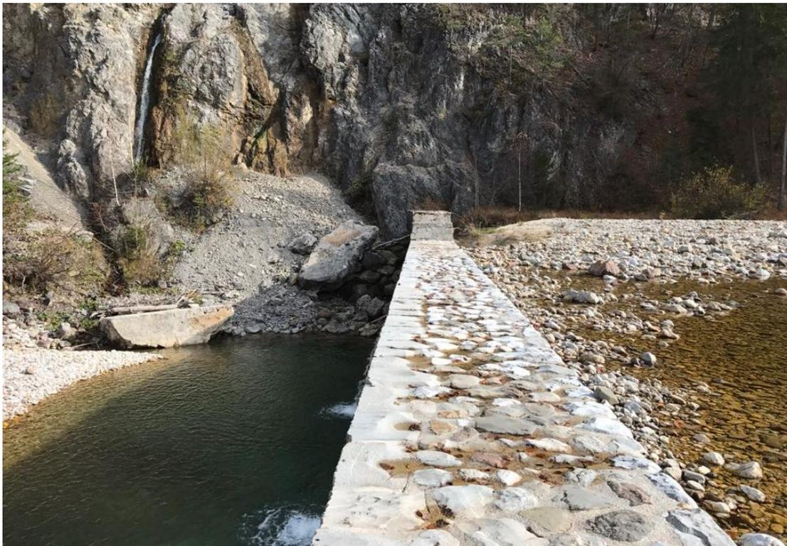
**Fig.6-16:** Particolare della gaveta e dell'ala destra della briglia di sbarramento della presa 495 sul torrente Slizza. A valle della briglia dovrebbe esserci la scala di risalita per pesci, la bocca di presa si trova in sponda sinistra.
