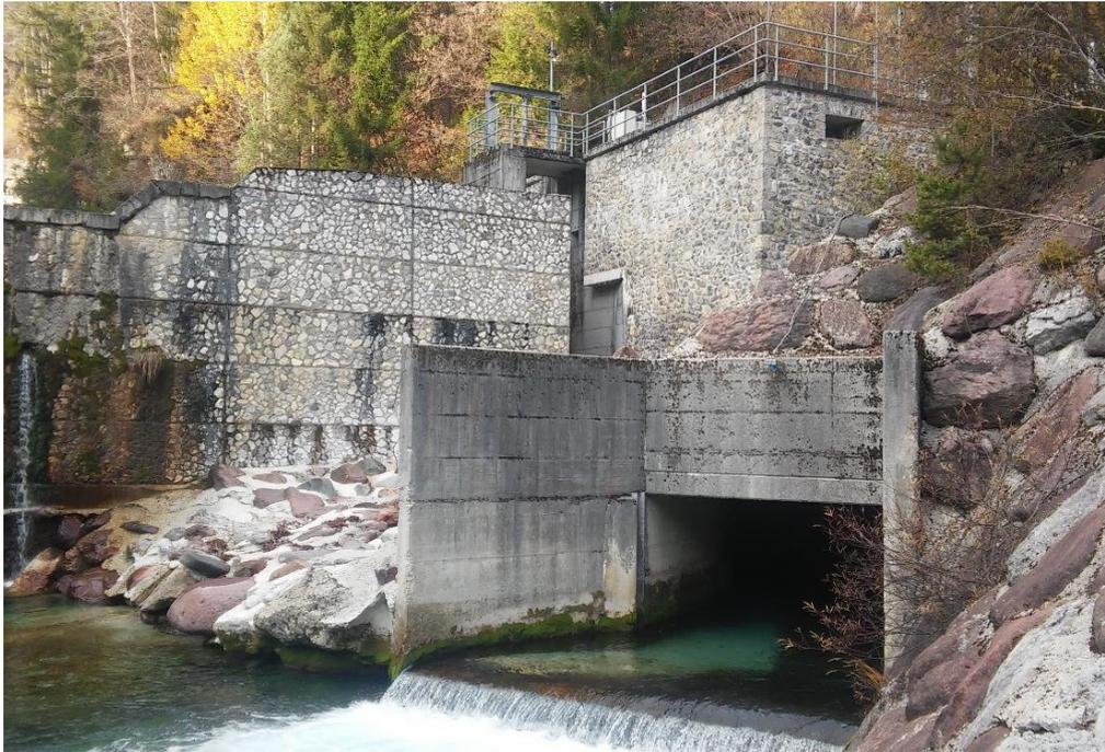
**Fig.8-9:** Scogliera in massi cementati per il deflusso delle portate di scarico tra restituzione e paratoia.
