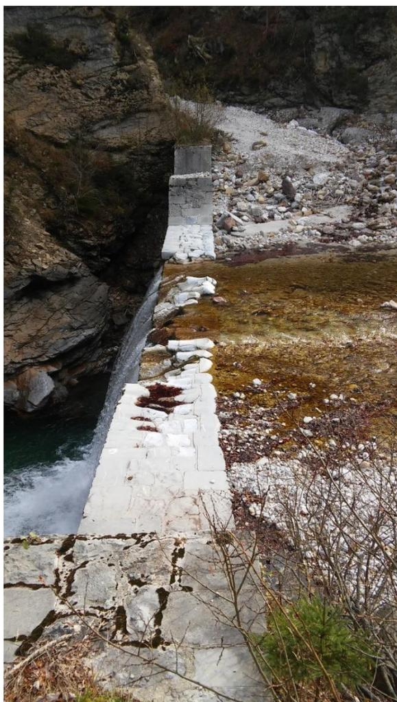
**Fig.3-12:** Particolare della gaveta e dell'ala di una briglia di difesa realizzata nel 1970 sul torrente Slizza. Torrente in condizioni di magra e sedimenti trasportati da affluente in destra idrografica.
